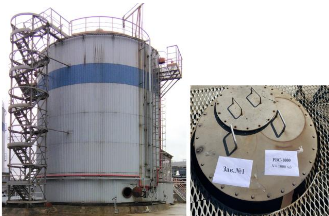
Рисунок 1 – Общий вид резервуара PBC-1000 № 1
