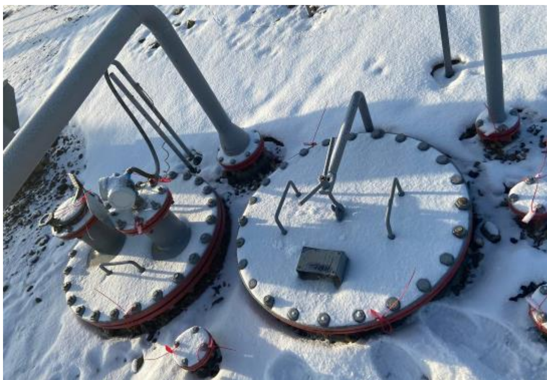
Рисунок 2 – Горловины резервуара ЕП-5 зав.№3400
