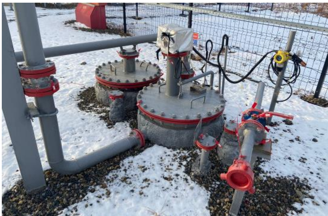
Рисунок 3 – Горловины резервуара ЕП-5 зав.№3403
