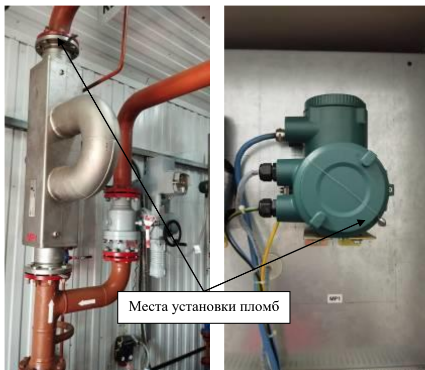
Рисунок 2 – Схема пломбировки от несанкционированного доступа
