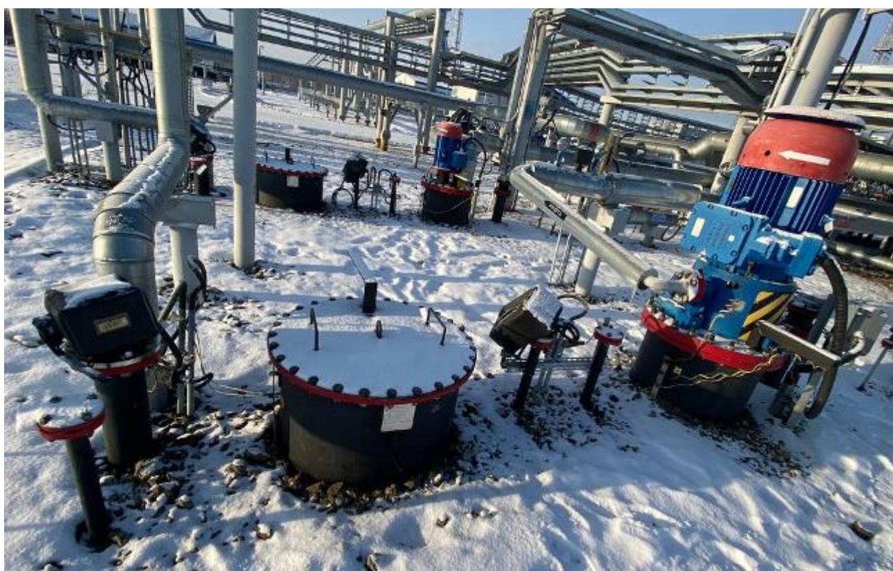
Рисунок 2 – Горловины и измерительный люк резервуара ЕП-16-2000-1300 зав.№ 607
