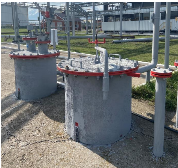
Рисунок 2 – Горловины и замерный люк резервуара.
