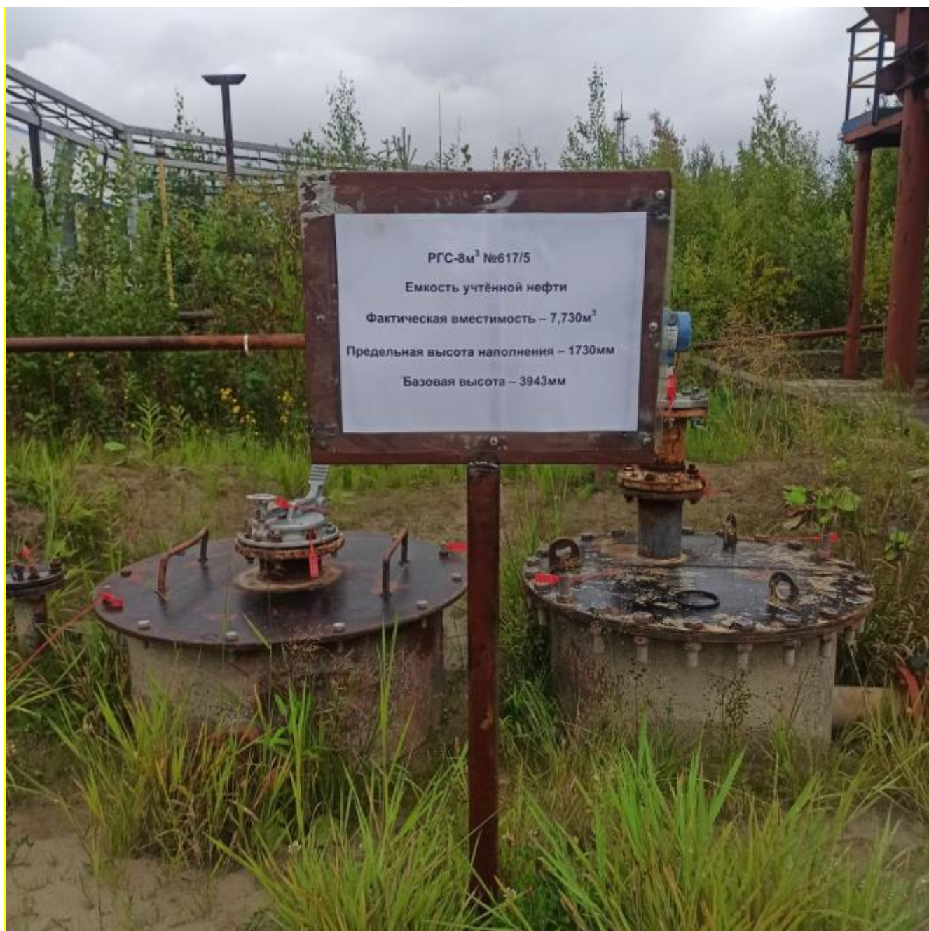
Рисунок 1 – Общий вид резервуара РГС-8
