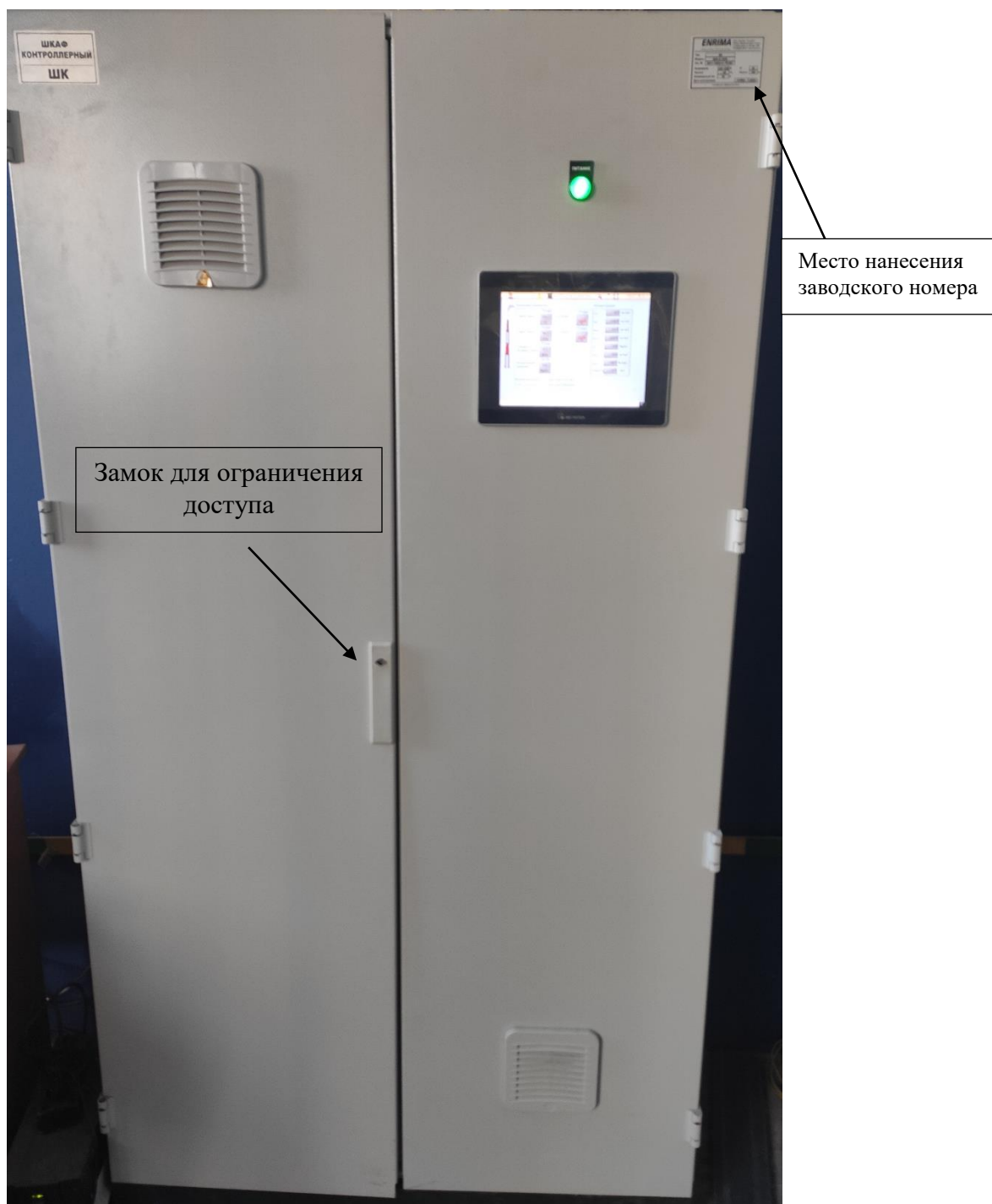
Рисунок 5 – Общий вид контроллерного шкафа
