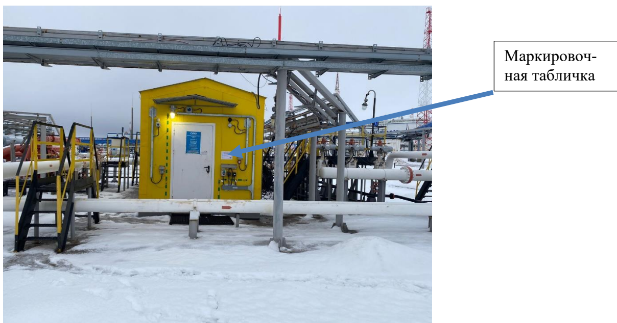
Рисунок 1 – Общий вид СИКН и место нанесения заводского номера на маркировочной табличке
