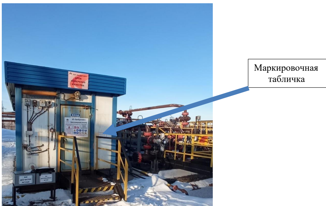
Рисунок 1 – Общий вид СИКН и место нанесения заводского номера на маркировочной табличке
