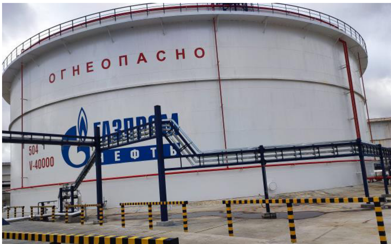
Рисунок 1 – Общий вид резервуара РВСПК-40000 №504
