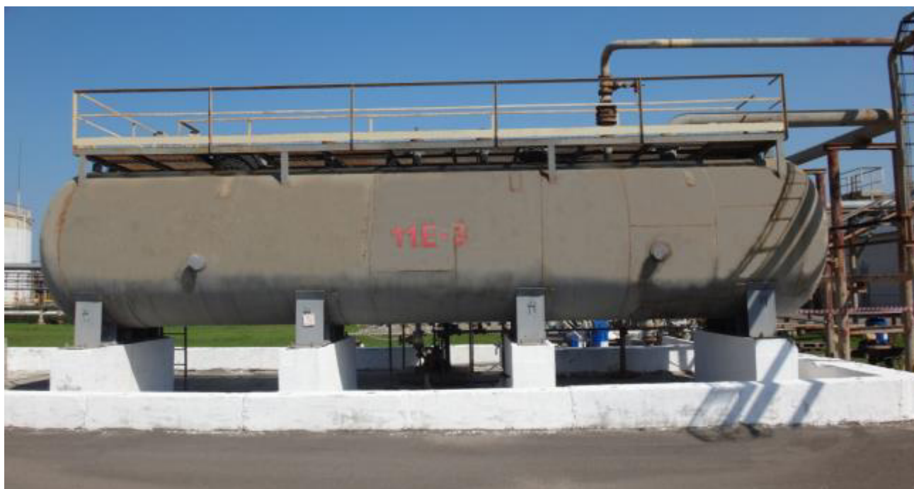
Рисунок 1 – Общий вид резервуара РГС-100
