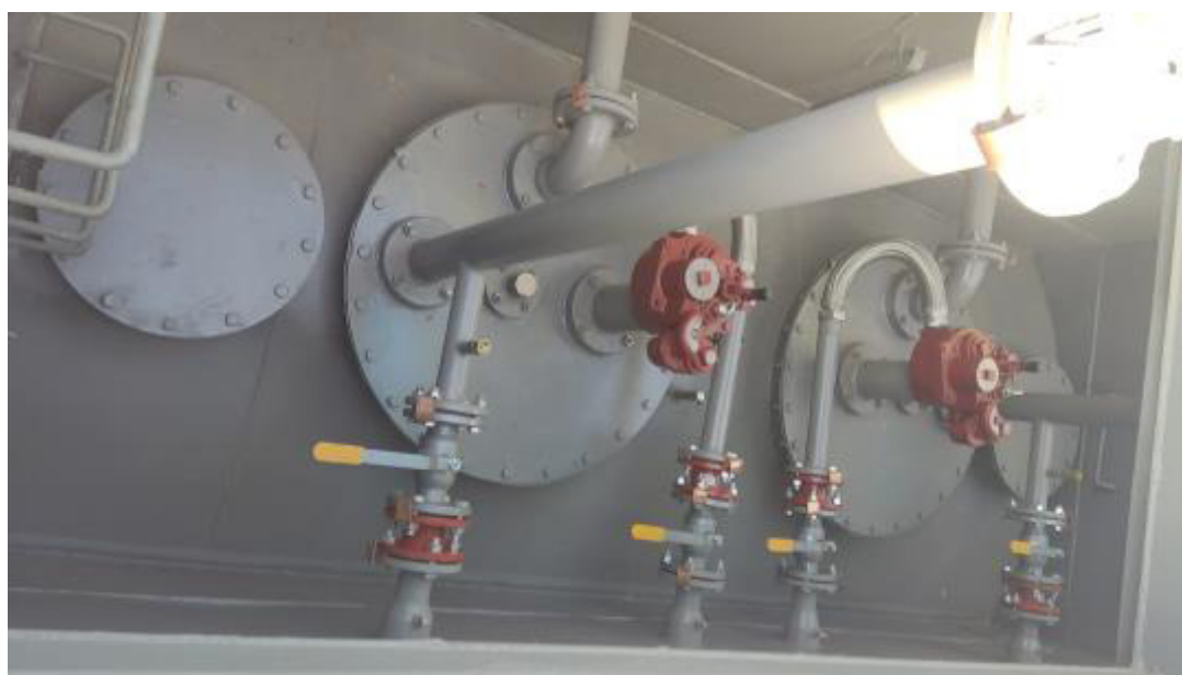
Рисунок 3 – Горловины и измерительные люки резервуара СРП (35+15) зав.№ 1195 Пломбирование резервуара СРП (35+15) не предусмотрено.
