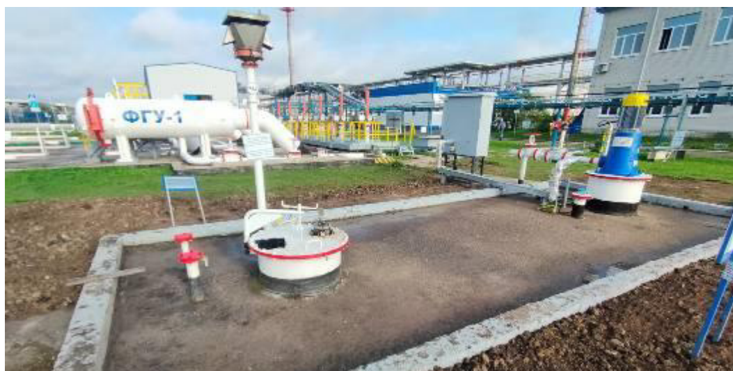
Рисунок 2 – Фотография горловины и крышки замерного люка резервуара
