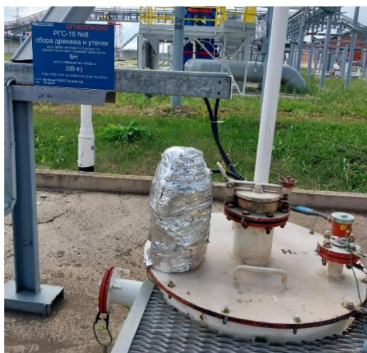
Рисунок 1 – Фотография таблички, горловины и крышки замерного люка резервуара
