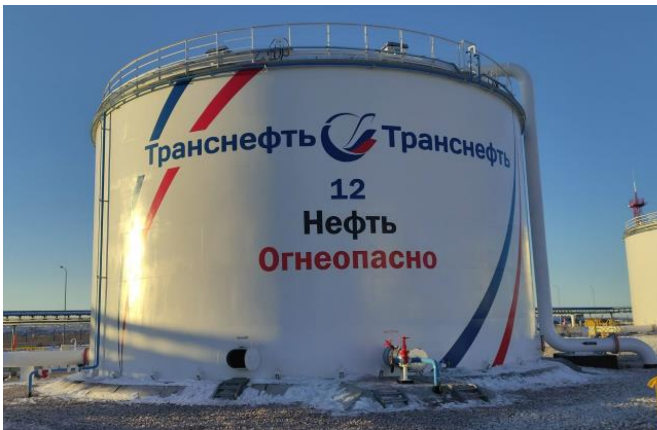
Рисунок 2 – Общий вид резервуара РВС-5000 №12
