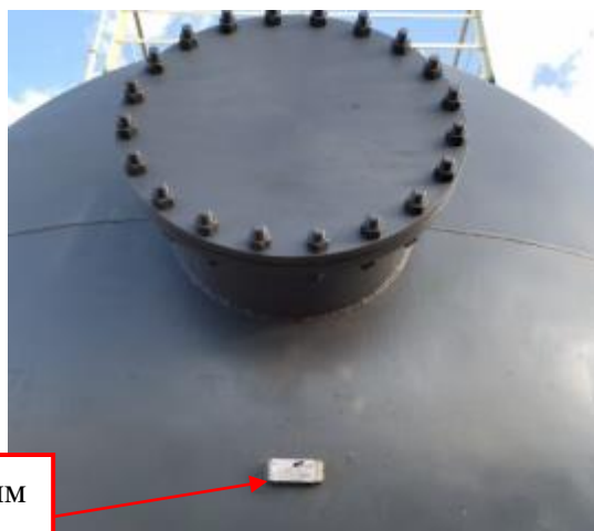
Рисунок 2 – Место установки таблички с заводским номером резервуара горизонтального стального цилиндрического РГС-85
