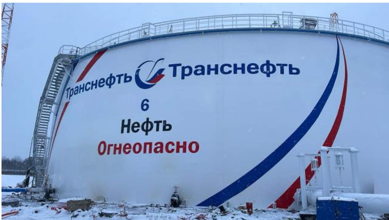
Рисунок 1 – Общий вид резервуара РВС-20000 зав.№ 6
