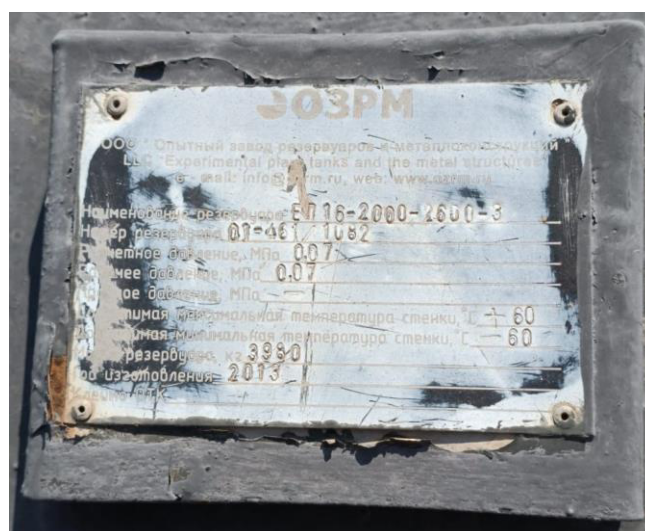
Рисунок 3 – Информационная табличка с заводским номером резервуара ЕП 16-2000-2600-3 зав.№ 01-461/1082
