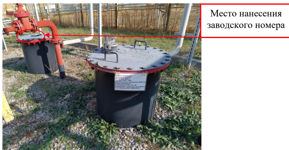
Рисунок 2 – Общий вид резервуара ЕП 16-2000-2600-3 зав.№ 01-461/1082
