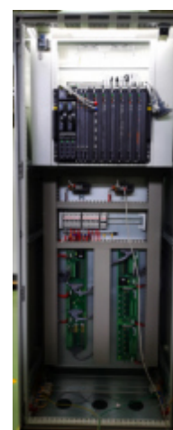
Стойка MC01 с расширительной стойкой EC01, с процессором PM01, модулями, AO1681, CM01, BI01, AI3281, OSP01, AO1681, VPM01
