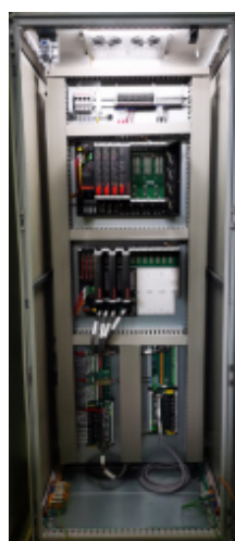
Стойка 8120X с модулями 8131X, 3009X, 4355X, 3902AX, 3809AX, 4701X, 3722X, 3723X, 3512X, 4701X
