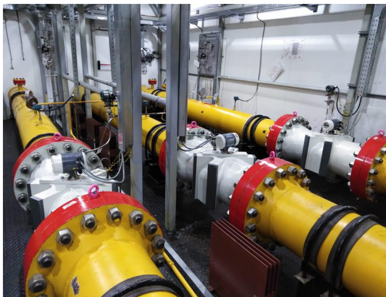
Рисунок 1 – Общий вид Системы измерений количества и показателей качества природного газа Комсомольского месторождения ООО «РН-Пурнефтегаз»
