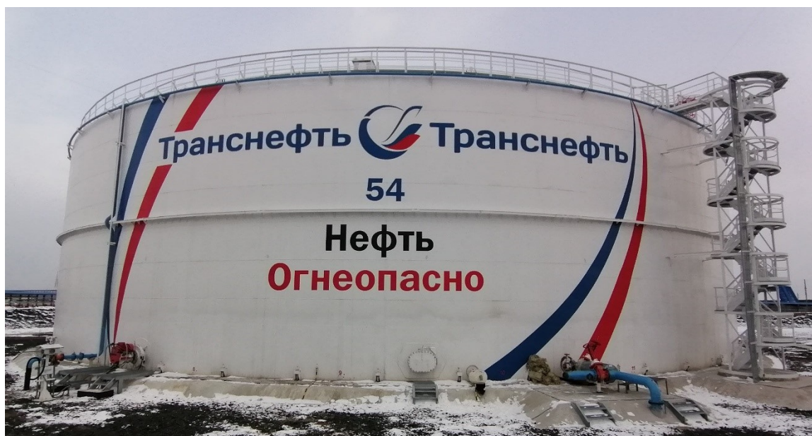
Рисунок 1 – Общий вид резервуара РВС-20000
