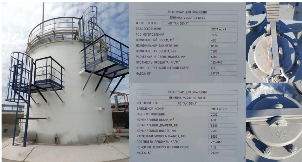
Рисунок 1 –Фотографии общего вида резервуаров вертикальных цилиндрических стальных с понтоном РВСП-400, горловин и заводских номеров
