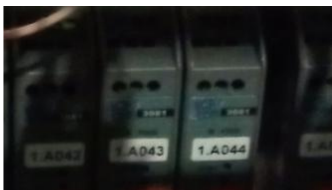
Рисунок 7 – Блоки гальванической развязки и преобразования тока в напряжение ICP DAS SG-3081
