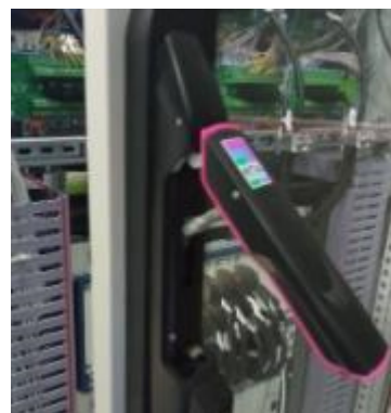
Рисунок 4 – Стойка СИ1. Запирающий механизм
