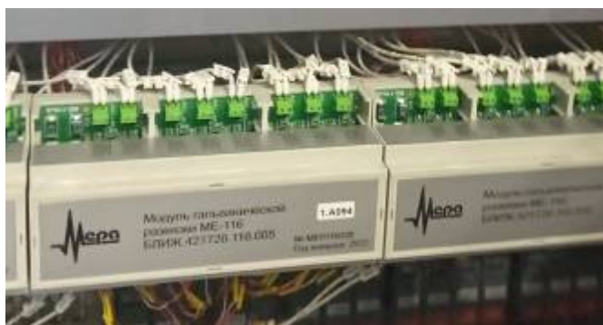
Рисунок 5 – Модуль гальванической развязки ME-116 в стойке СИ2
