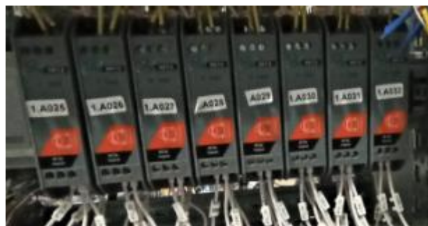
Рисунок 6 – Блоки гальванической развязки и преобразования сопротивления в напряжение ICP DAS SG-3013
