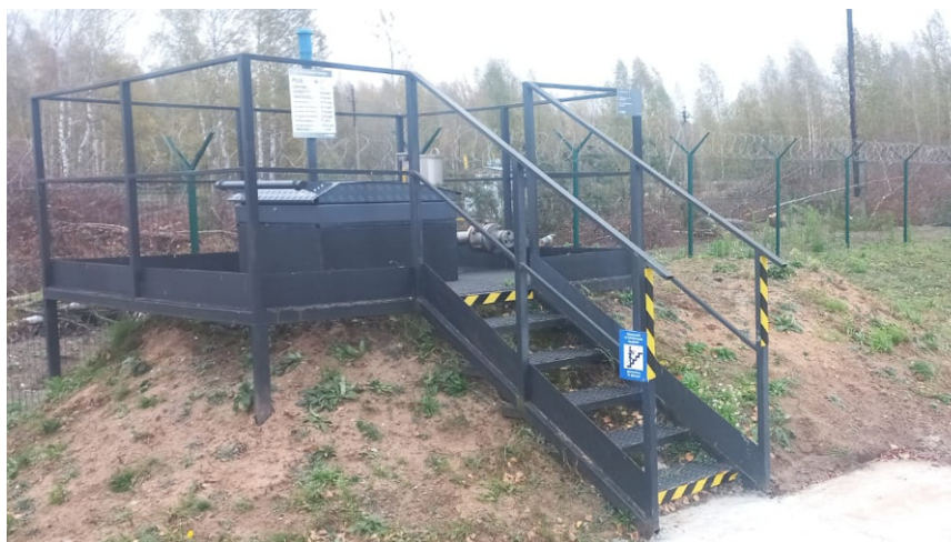
Рисунок 1 – Общий вид резервуара РГС-25
