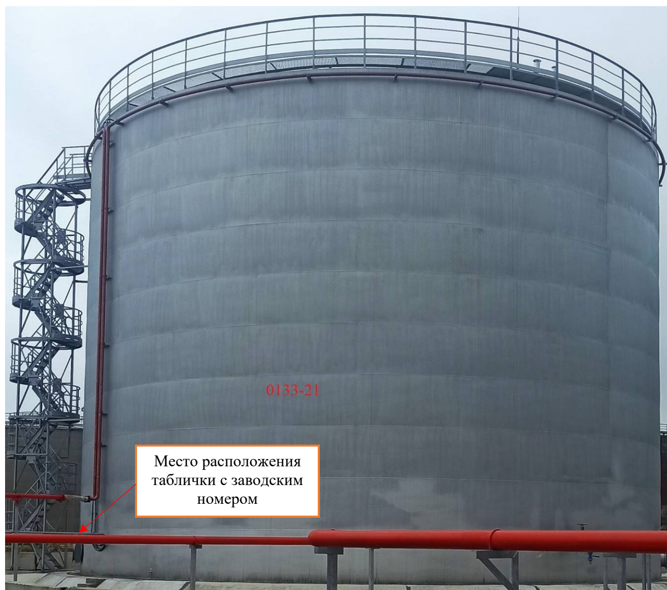
Рисунок 1 - Общий вид резервуара вертикального стального цилиндрического РВС-5000 с указанием места расположения таблички с заводским номером
