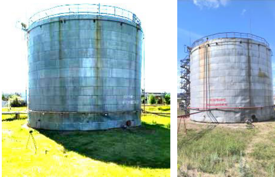
Рисунок 1 - Общий вид резервуаров стальных вертикальных цилиндрических РВС-2000
