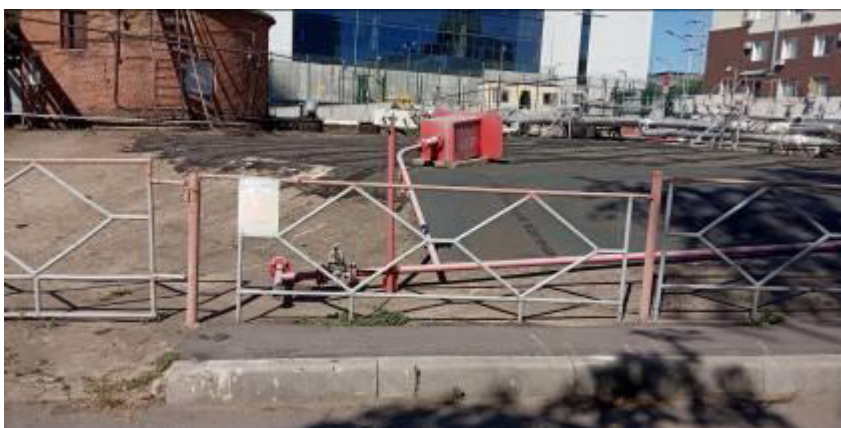
Рисунок 1 - Общий вид резервуаров железобетонных цилиндрических ЖБР-2000
