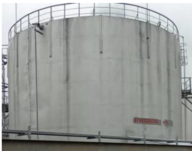
Рисунок 1 - Общий вид резервуаров стальных вертикальных цилиндрических РВС-2000
