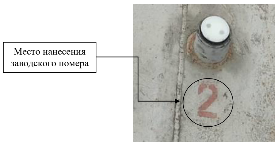
Р и с у н о к 3 – Общий вид замерного люка и место нанесения заводского номера
