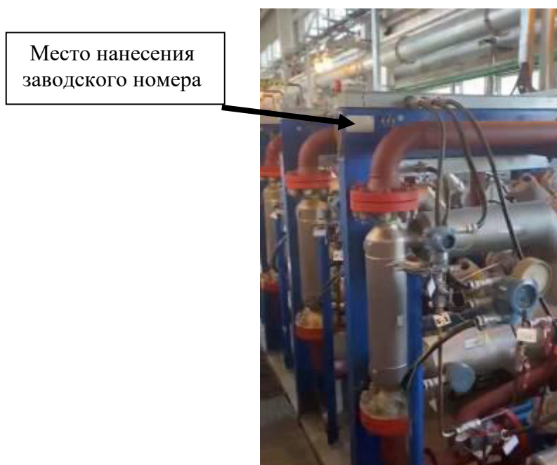
Рисунок 4 – Стойка БИЛ Системы с маркировочной табличкой, на которой нанесен заводской номер
