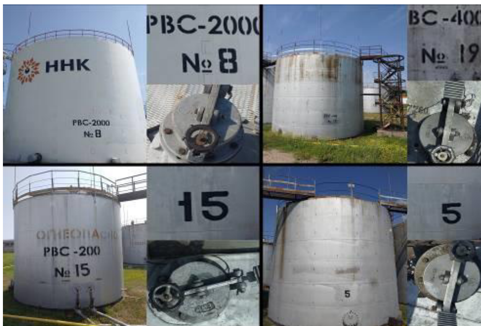
Рисунок 1 – Фотографии общего вида резервуаров стальных вертикальных цилиндрических PBC-200, PBC-400, PBC-2000, горловин замерных люков и заводских номеров
