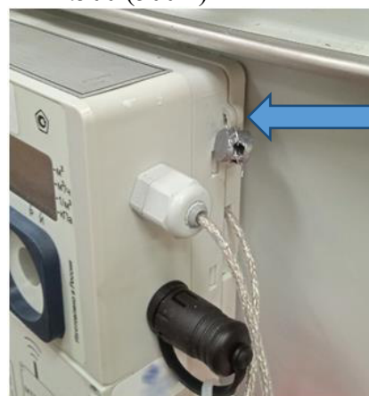
Монтаж термопреобразователя сопротивления Pt500 (500П) на корпусе счетчика
