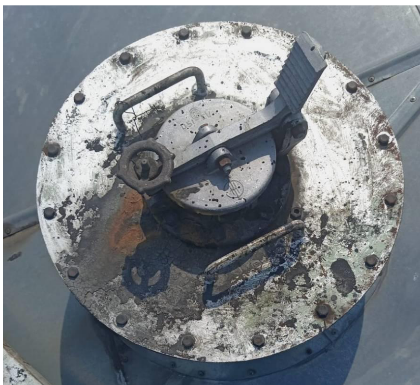
Рисунок 2 – Фото замерного люка резервуара РВС-20000 зав.№ РМ-2
