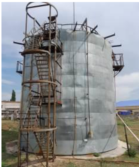
Рисунок 1 – Общий вид резервуара стального вертикального цилиндрического РВС-1000
