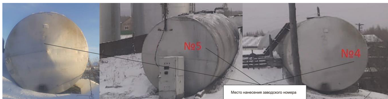
Рисунок 1 – Общий вид резервуаров горизонтальных стальных цилиндрических РГС с указанием места нанесения заводских номеров
