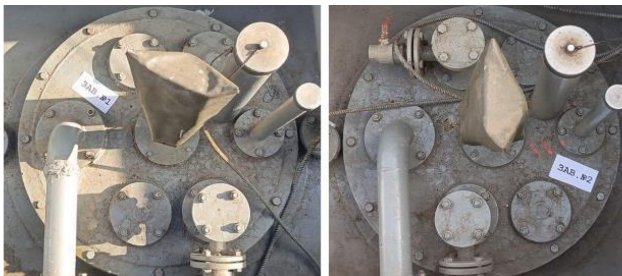
Рисунок 2 – Горловины резервуаров РГС-25 зав.№№ 1, 2
