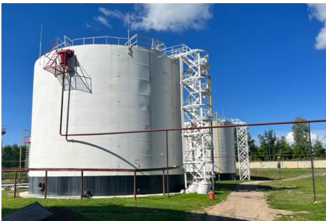
Рисунок 2 – Общий вид резервуара РВС-2000 №5
