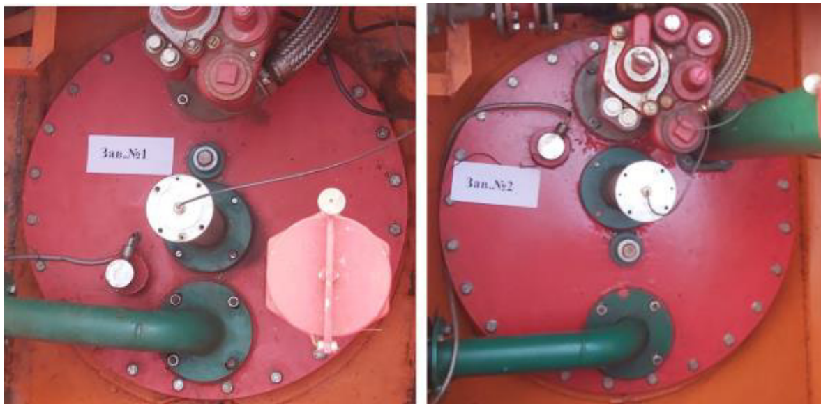
Рисунок 3 – Горловины резервуаров РГС-25 зав.№№ 1, 2
