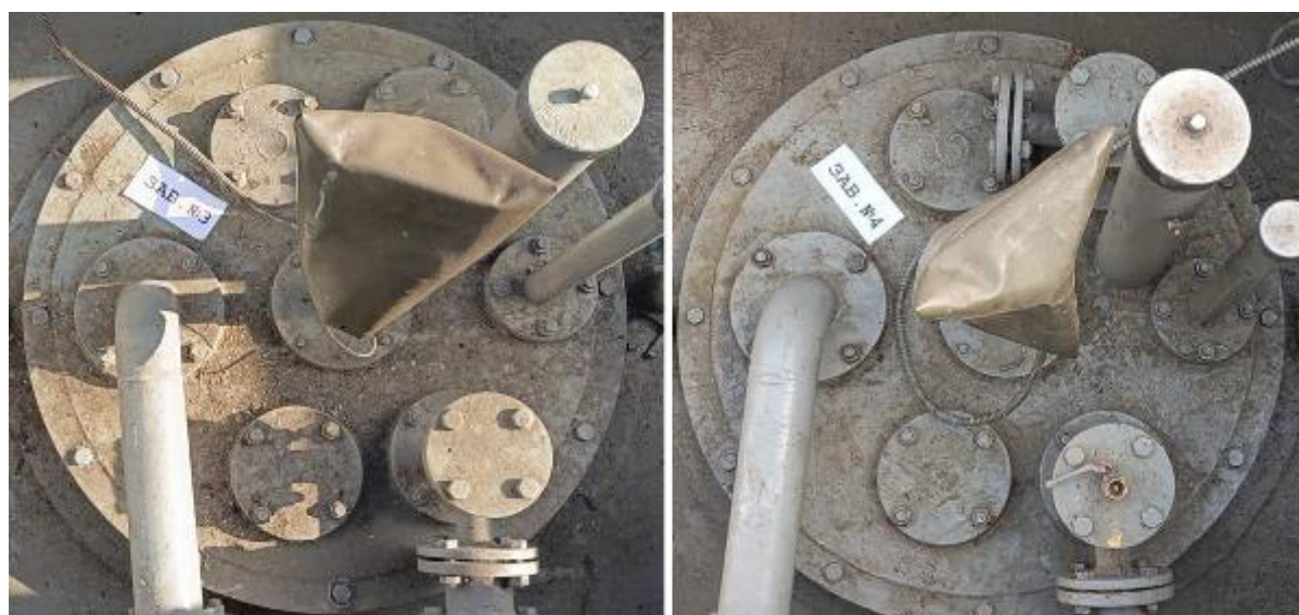
Рисунок 3 – Горловины резервуаров РГС-25 зав.№№ 3, 4
