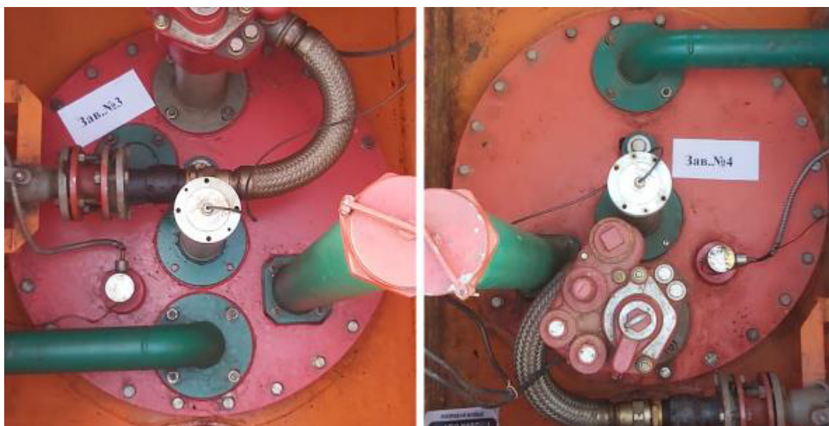
Рисунок 4 – Горловины резервуаров РГС-25 зав.№№ 3, 4
