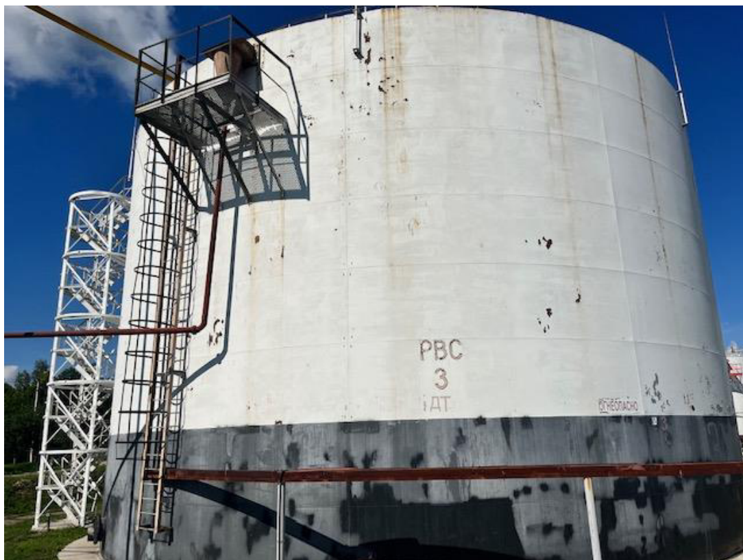
Рисунок 3 – Общий вид резервуара РВС-3000 №3
