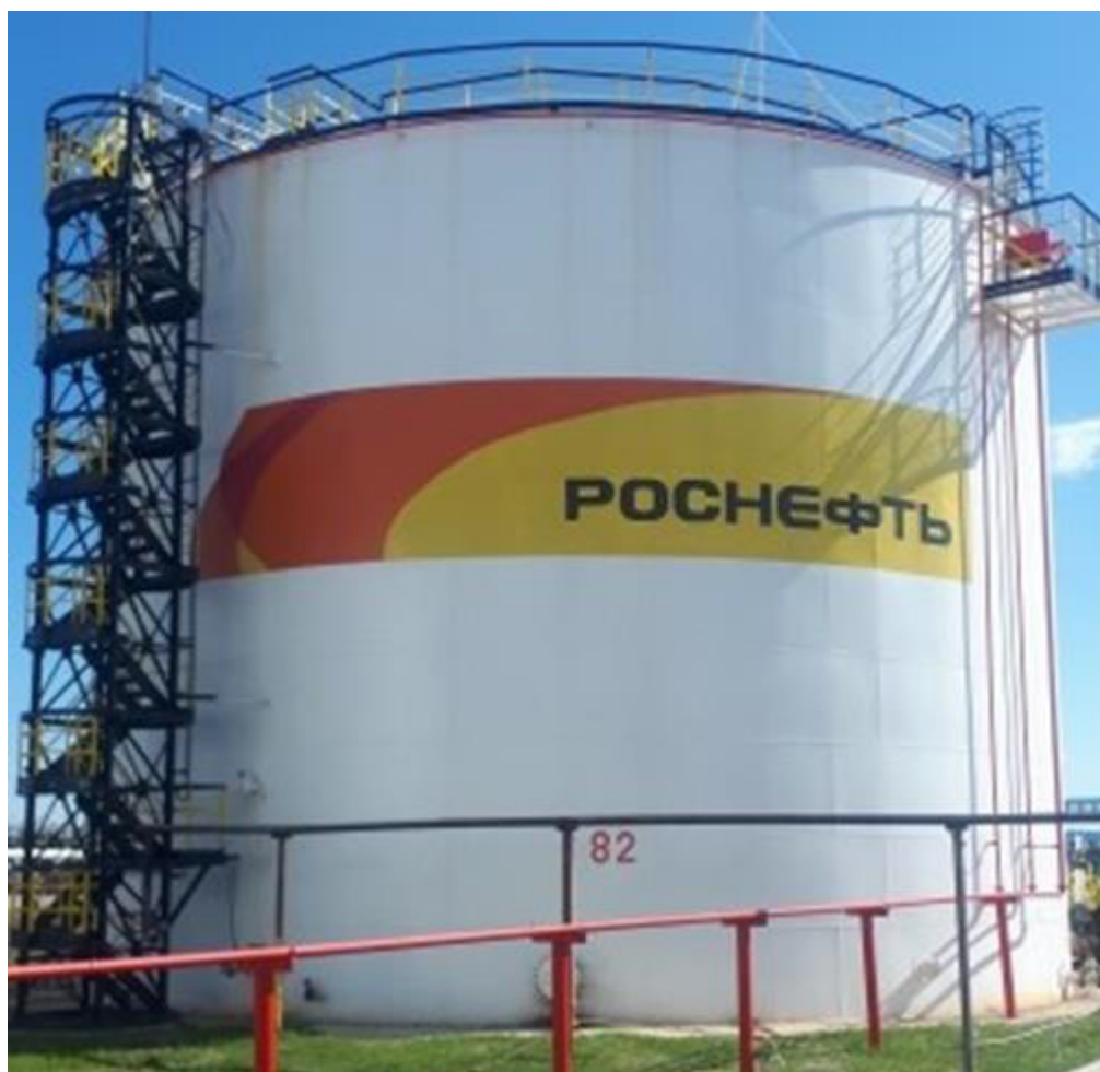
Рисунок 1 – Общий вид резервуара РВСП-5000 №82
