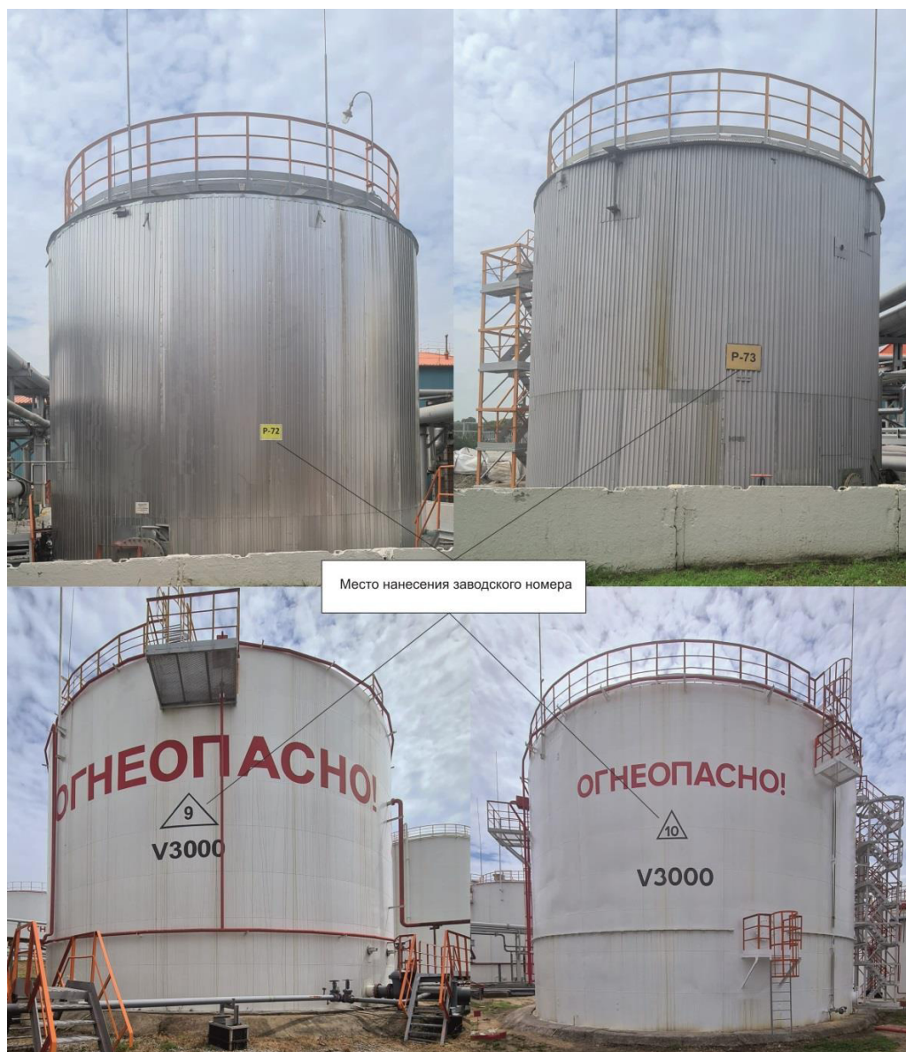
Рисунок 1 – Общий вид резервуаров вертикальных стальных цилиндрических PVC с указанием места нанесения заводских номеров
