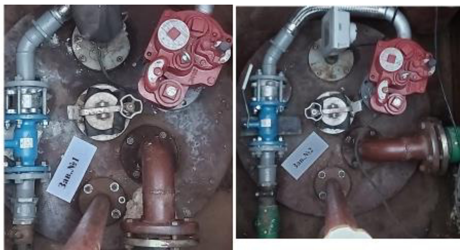
Рисунок 2 – Горловины резервуаров РГС-25 зав.№№ 1, 2
