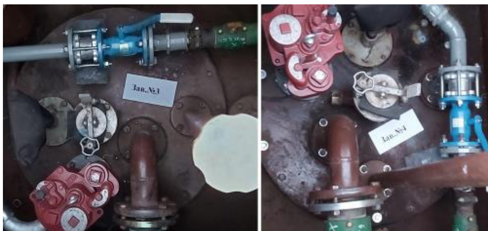
Рисунок 3 – Горловины резервуаров РГС-25 зав.№№ 3, 4
