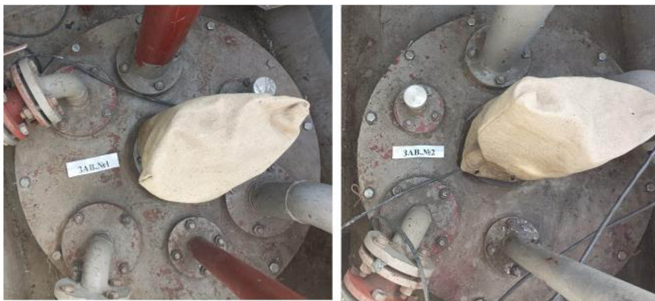
Рисунок 2 – Горловины резервуаров РГС-25 зав.№№ 1, 2
