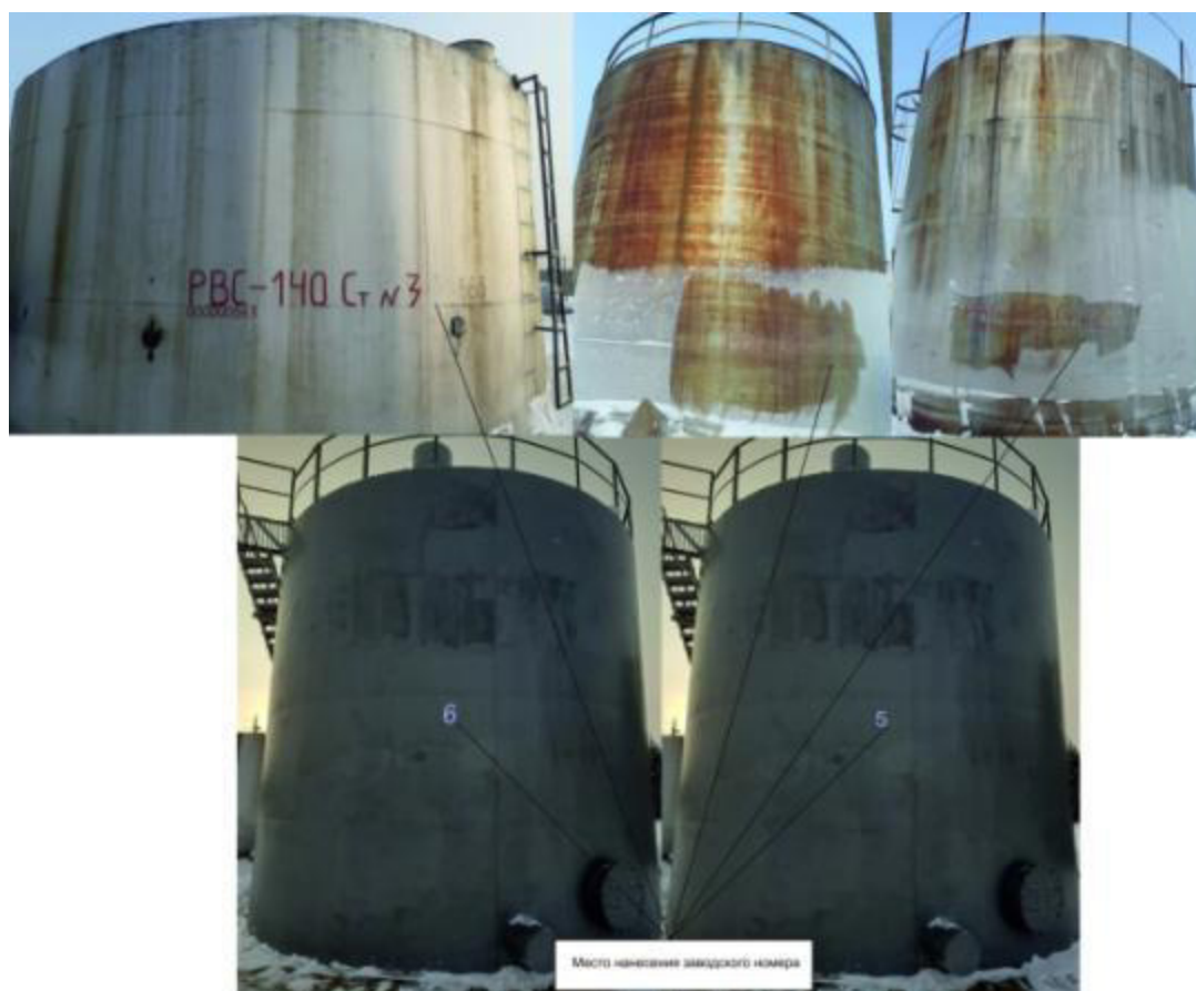
Рисунок 1 – Общий вид резервуаров вертикальных стальных цилиндрических РВС с указанием места нанесения заводских номеров
