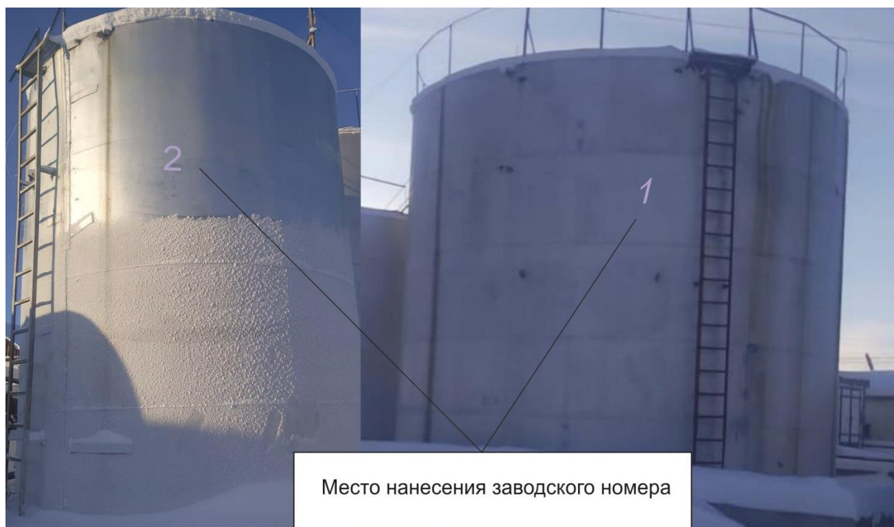
Рисунок 1 – Общий вид резервуаров вертикальных стальных цилиндрических РВС с указанием места нанесения заводских номеров
