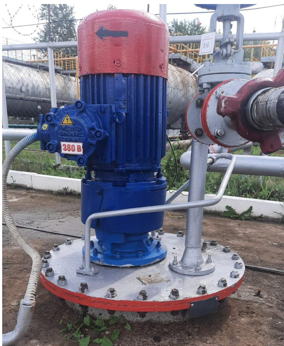
Рисунок 2 – Горловина резервуара ЕП-50-2400-1
