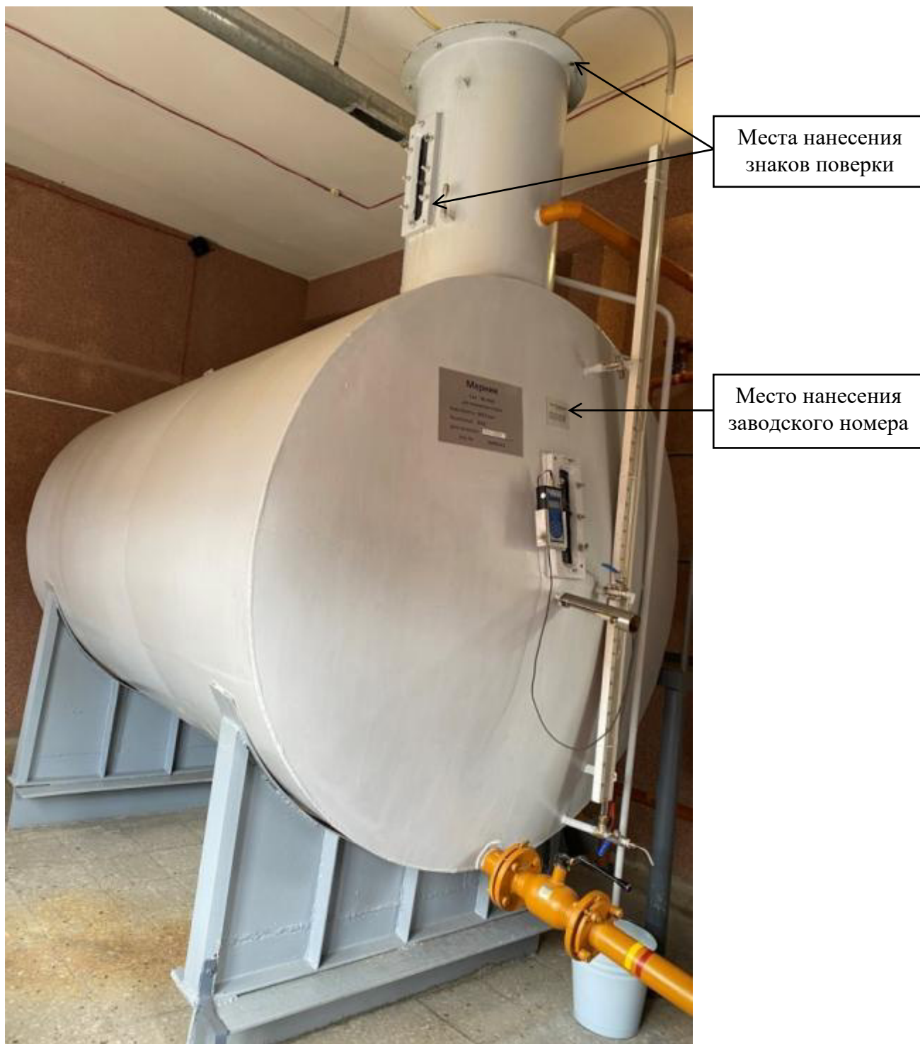
Рисунок 1 – Общий вид мерника стационарного металлического технического 1-го класса МСМТ-3 № 1929 с указанием мест пломбировки и места нанесения заводского номера
