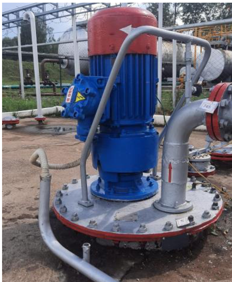
Рисунок 2 – Горловина и измерительный люк резервуара ЕП-10-2000-1-2
