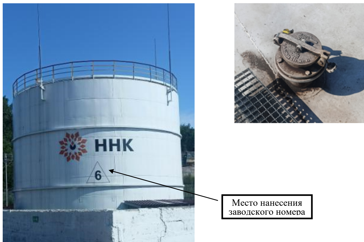
Рисунок 1 – Общий вид резервуара и замерного люка
