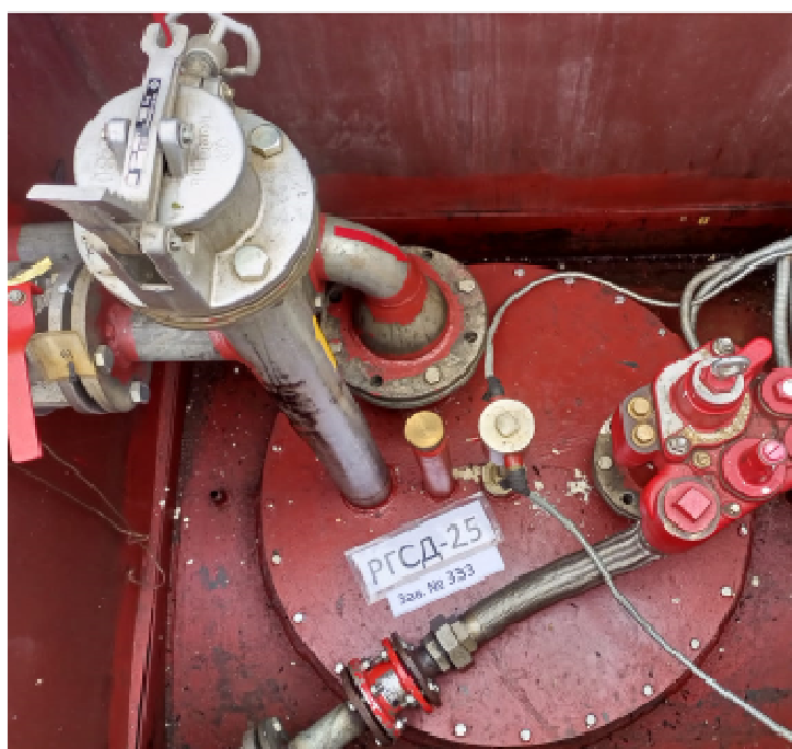
Рисунок 2 – Горловины и измерительные люки резервуаров РГСД-25 зав.№№ 333, 334
