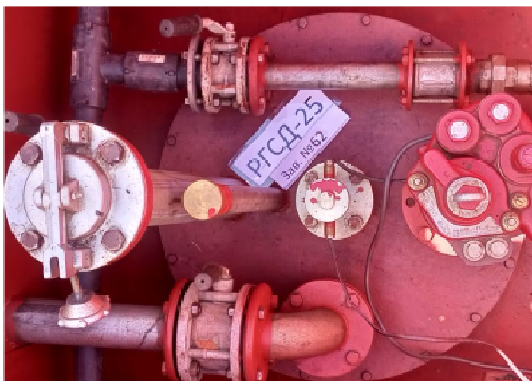
Рисунок 5 – Горловины и измерительные люки резервуаров РГСД-25 зав.№№ 62, 63 Пломбирование резервуаров РГСД-25 не предусмотрено.
