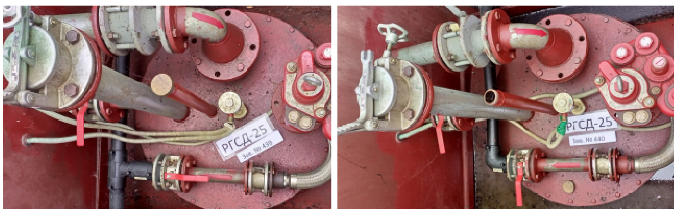
Рисунок 5 – Горловины и измерительные люки резервуаров РГСД-25 зав.№№ 439, 440 Пломбирование резервуаров РГСД-25 не предусмотрено.
