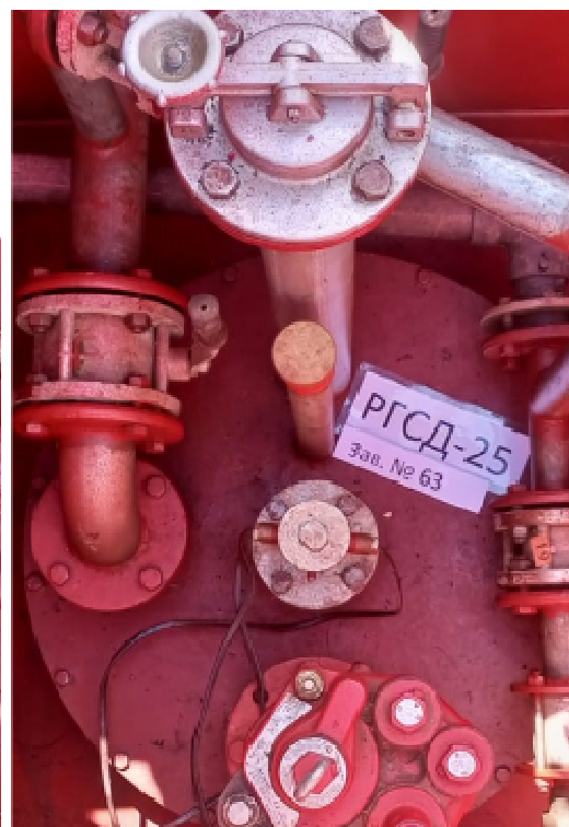
Рисунок 5 – Горловины и измерительные люки резервуаров РГСД-25 зав.№№ 62, 63 Пломбирование резервуаров РГСД-25 не предусмотрено.
