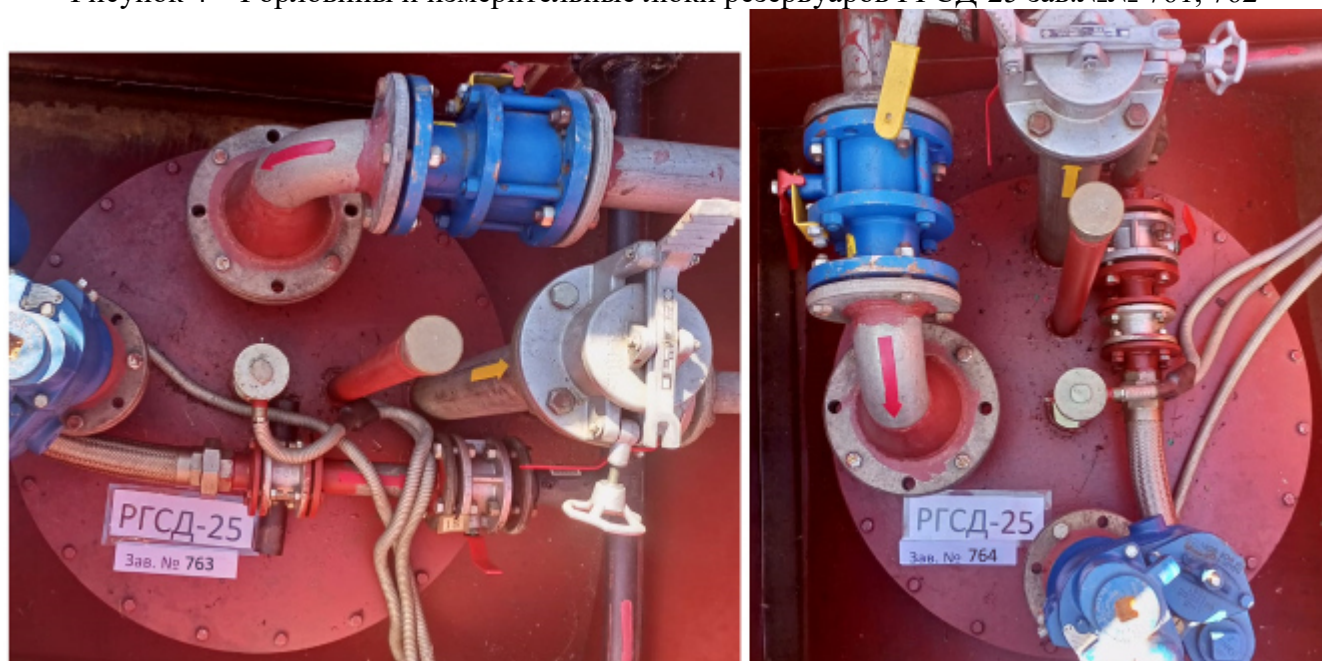
Рисунок 4 – Горловины и измерительные люки резервуаров РГСД-25 зав.№№ 761, 762
