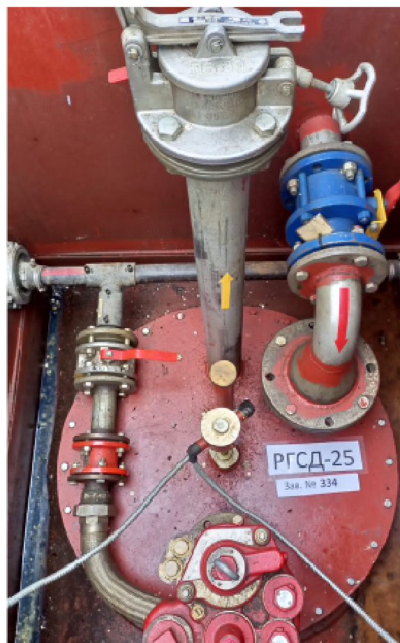
Рисунок 2 – Горловины и измерительные люки резервуаров РГСД-25 зав.№№ 333, 334
