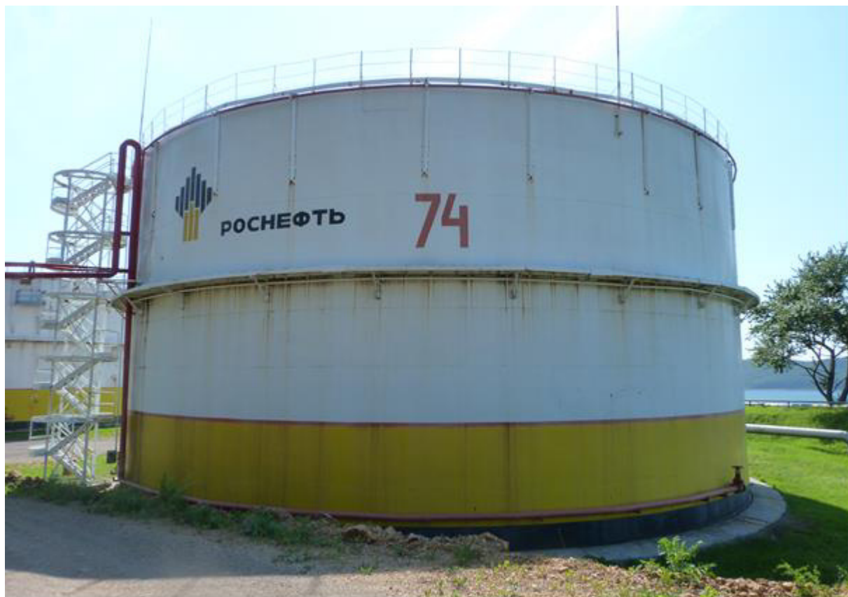
Рисунок 1 – Общий вид резервуара вертикального стального цилиндрического РВС-5000
