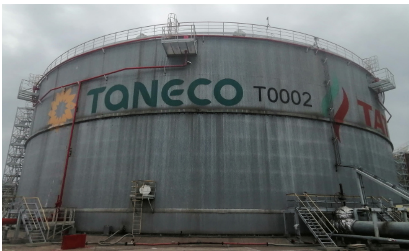
Рисунок 2 – Общий вид резервуара РВСП-50000 зав.№ Т0002
