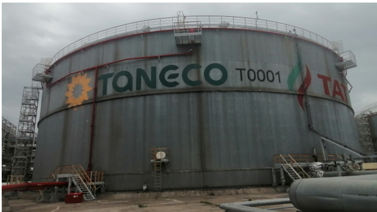
Рисунок 1 – Общий вид резервуара РВСП-50000 зав.№ Т0001
