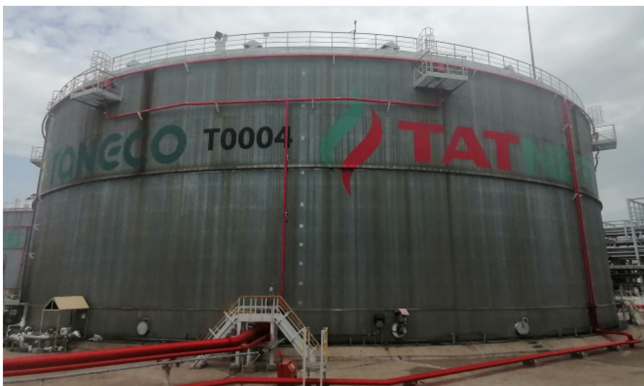
Рисунок 4 – Общий вид резервуара РВСП-50000 зав.№ Т0004
