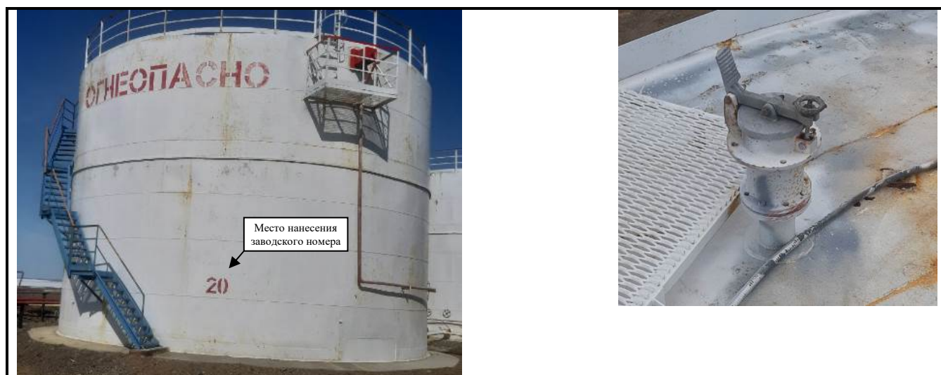
Рисунок 4 – Общий вид резервуара РВС-1000 (№20) с замерным люком
