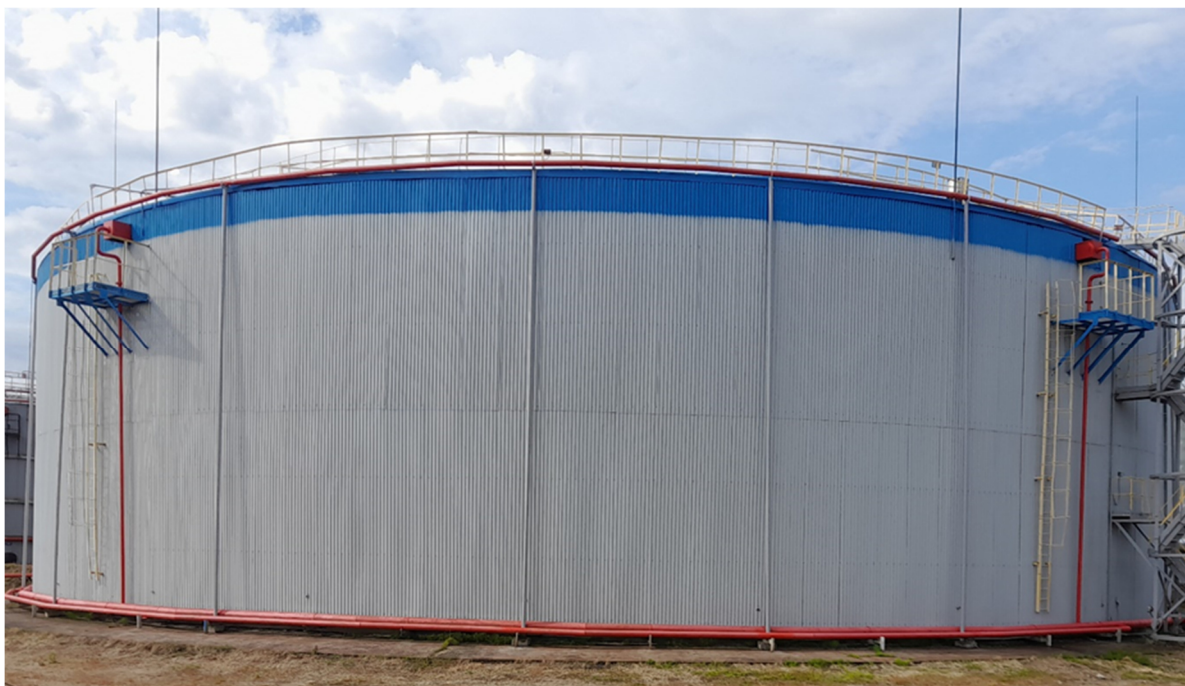
Рисунок 1 – Общий вид резервуара
