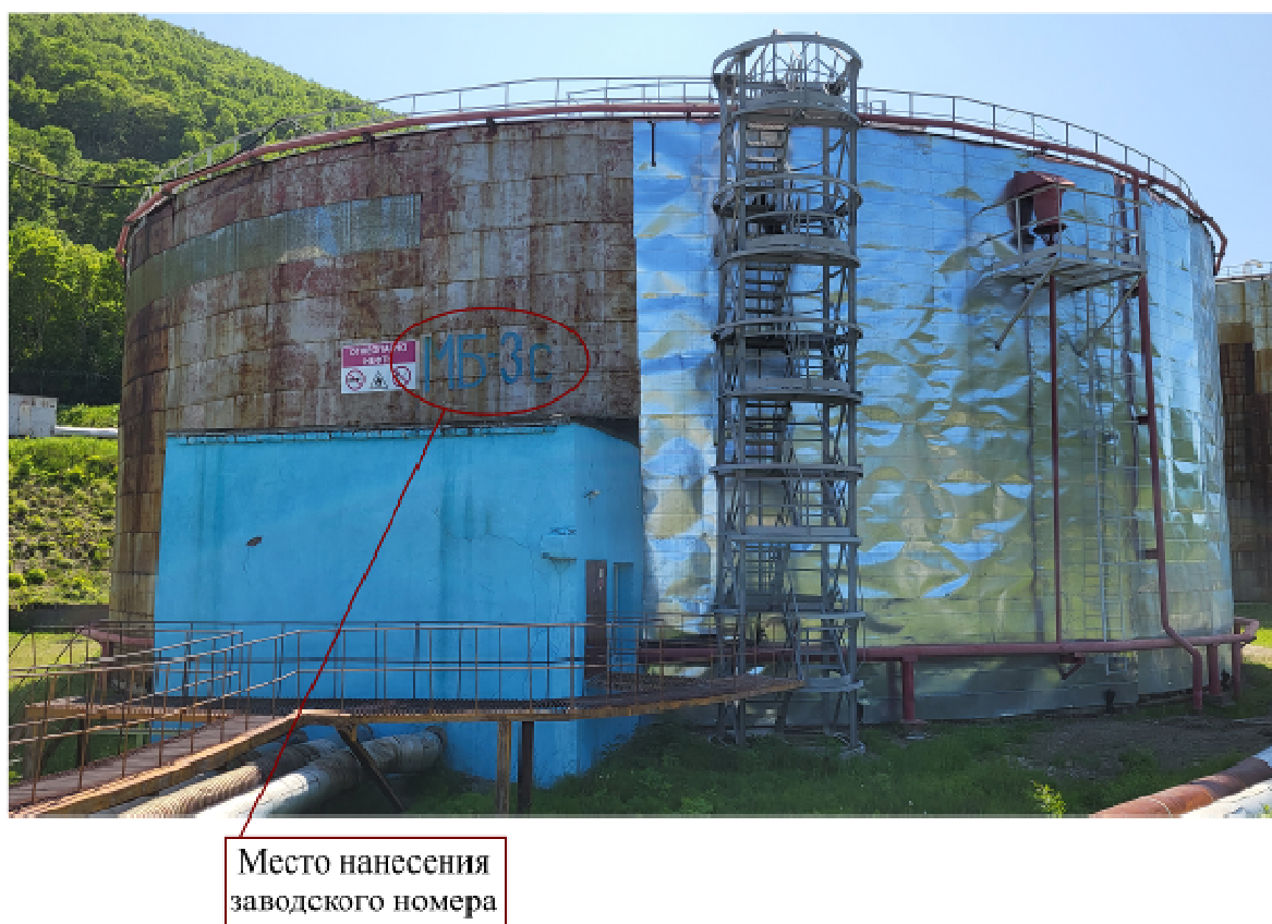
Рисунок 1 – Общий вид резервуара РВС-10000 зав.№ МБ-3с с указанием места нанесения заводского номера
