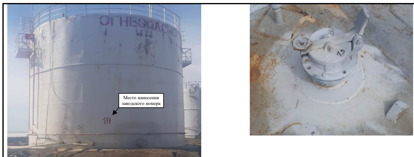
Рисунок 3 – Общий вид резервуара РВС-1000 (№19) с замерным люком
