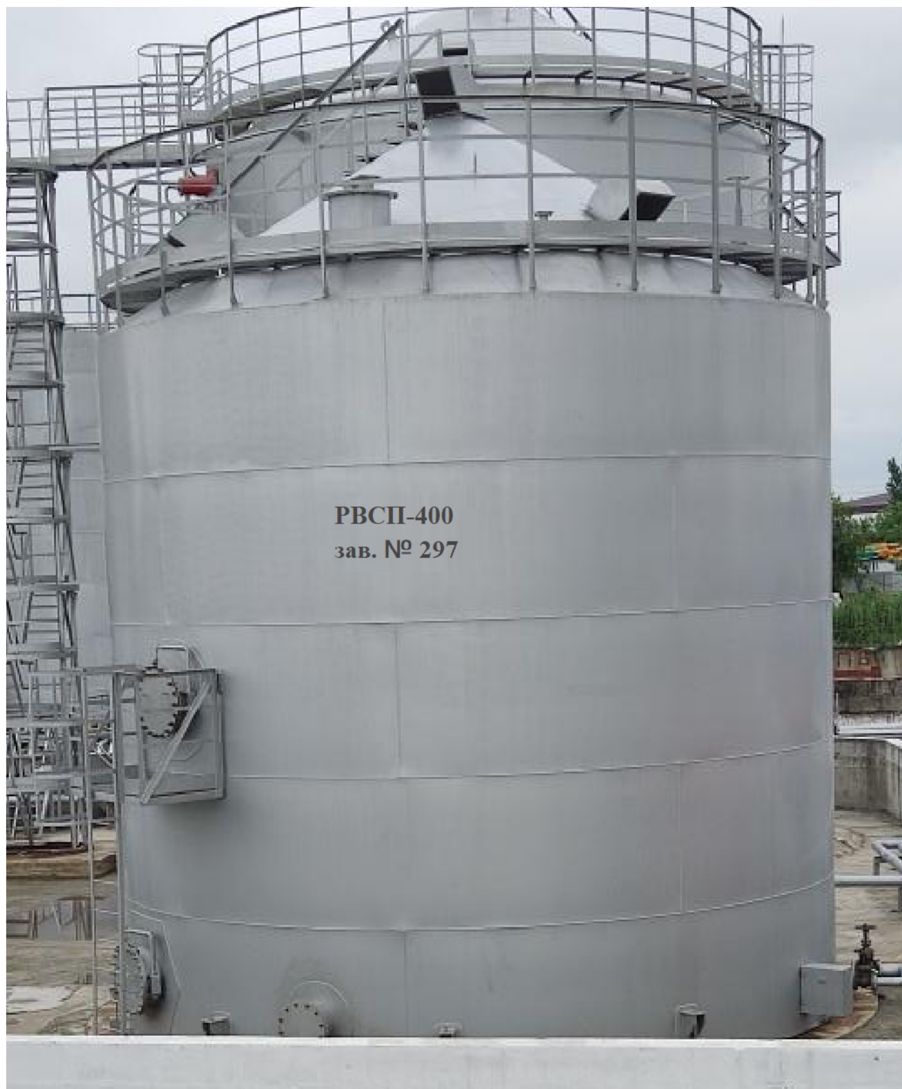
Рисунок 1 - Фотография общего вида резервуара РВСП-400 заводской номер 297
