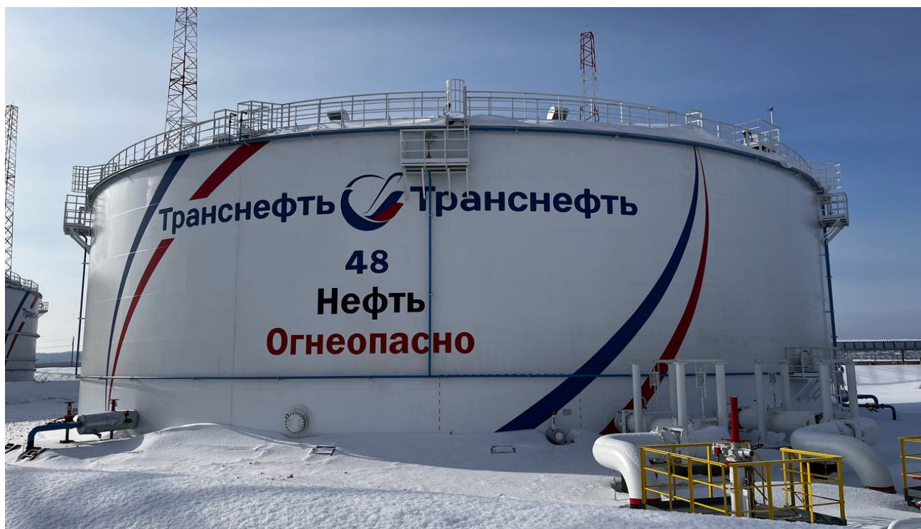
Рисунок 1 – Общий вид резервуара РВСП-20000 зав.№48
