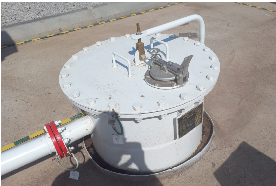
Рисунок 3 – Горловина и измерительный люк резервуара ЕП-40-2400-600-А-СО-У1 зав.№ 7211
