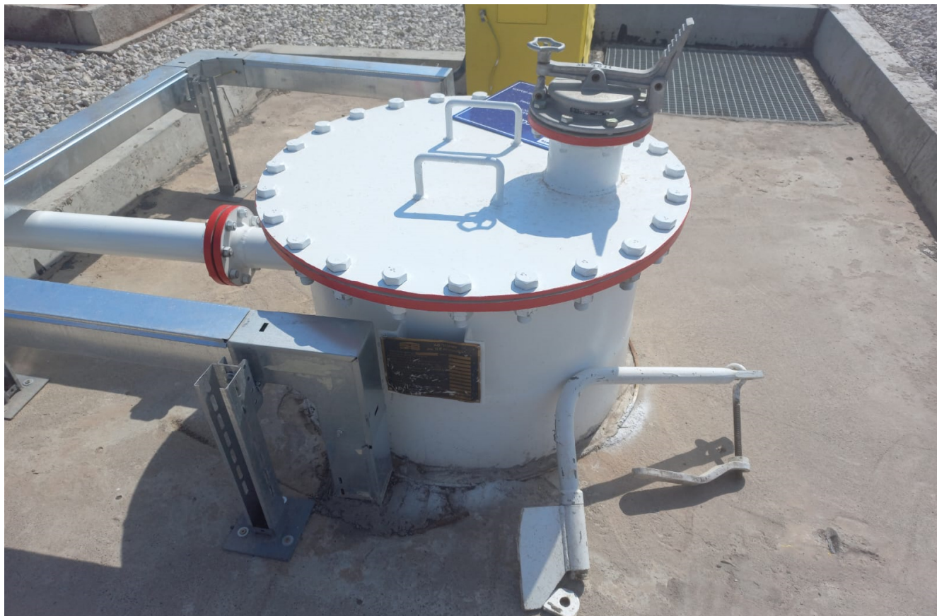
Рисунок 3 – Горловина и измерительный люк резервуара ЕП-40-2400-2-А-СО-У1 зав.№ 7210
