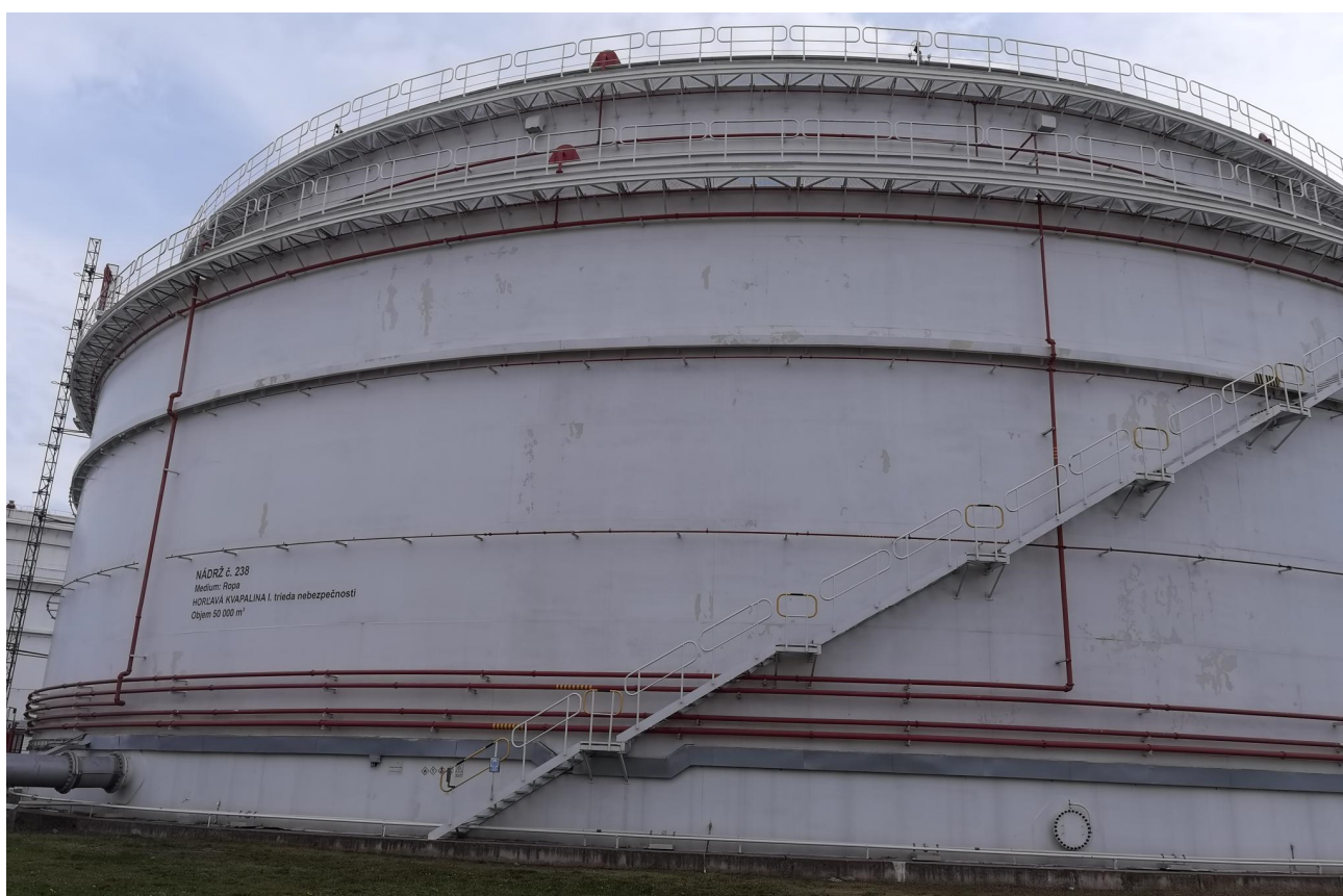
Рисунок 2 – Общий вид резервуара РВСПК-50000 зав.№ 238
