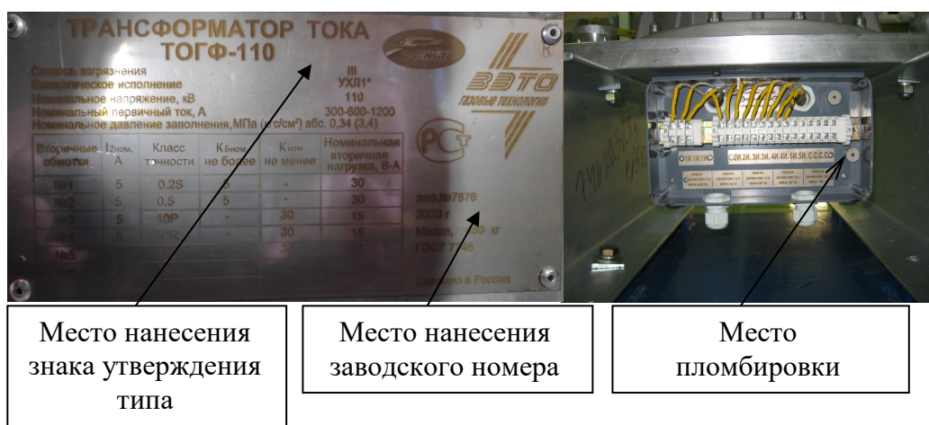
Рисунок 6 - Общий вид таблички и клеммной коробки трансформатора с указанием места пломбировки от несанкционированного доступа, места нанесения знака утверждения типа, заводского номера
