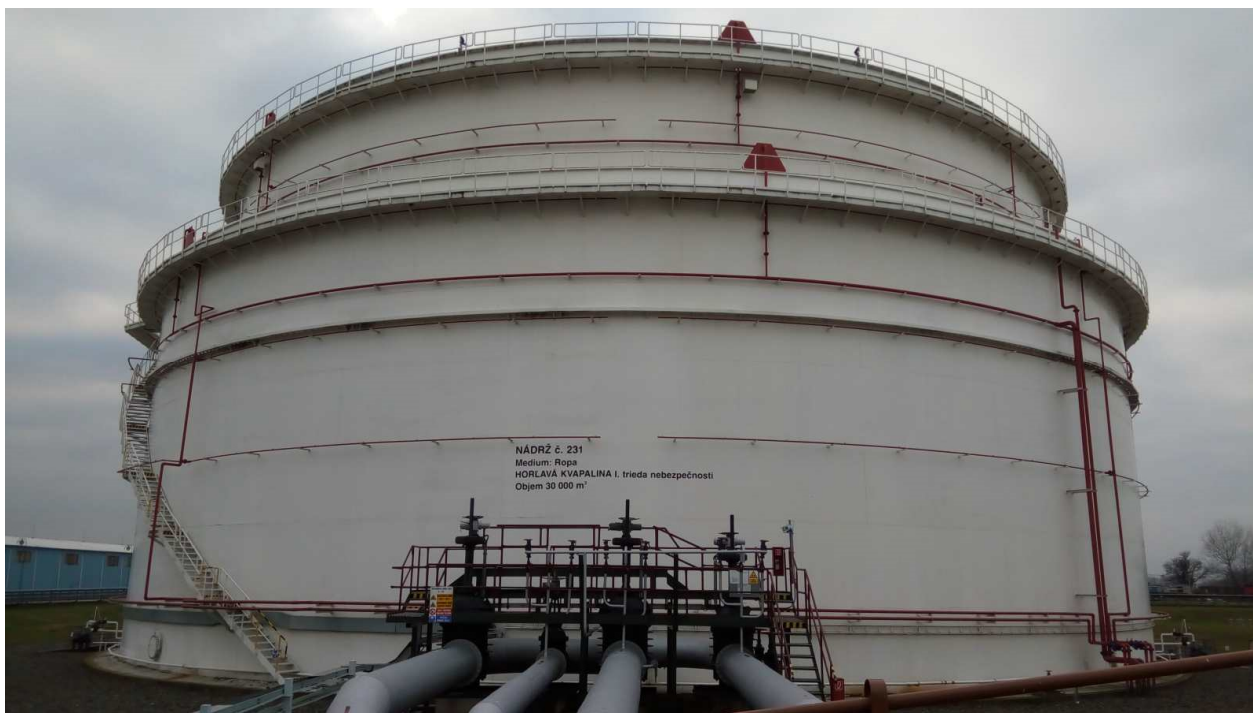
Рисунок 1 – Общий вид резервуара РВСПК-30000 зав.№ 231
