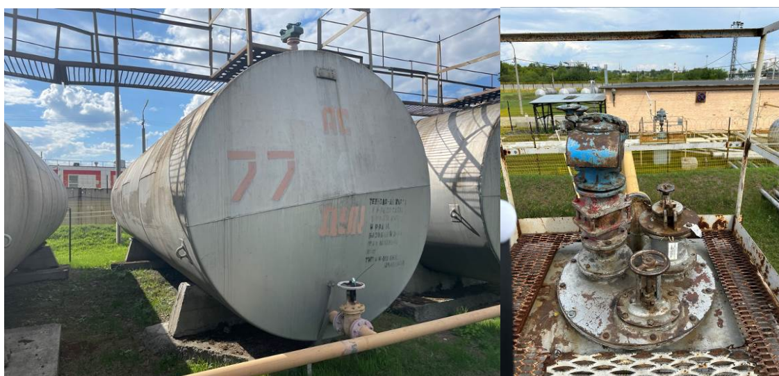
Рисунок 4 – Общий вид резервуара и замерного люка РГС-60 зав.№ 77
