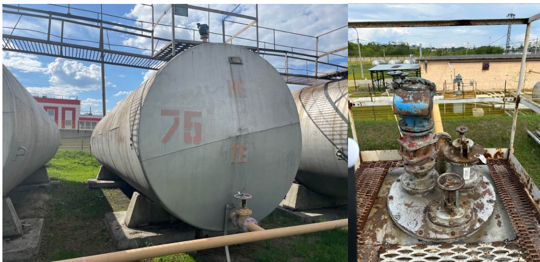
Рисунок 2 – Общий вид резервуара и замерного люка РГС-60 зав.№ 75
