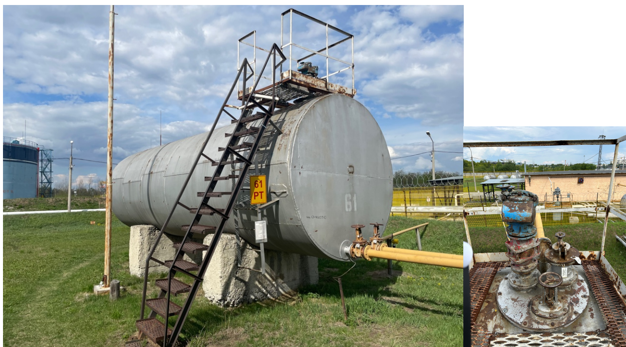
Рисунок 1 – Общий вид резервуара и замерного люка РГС-50
