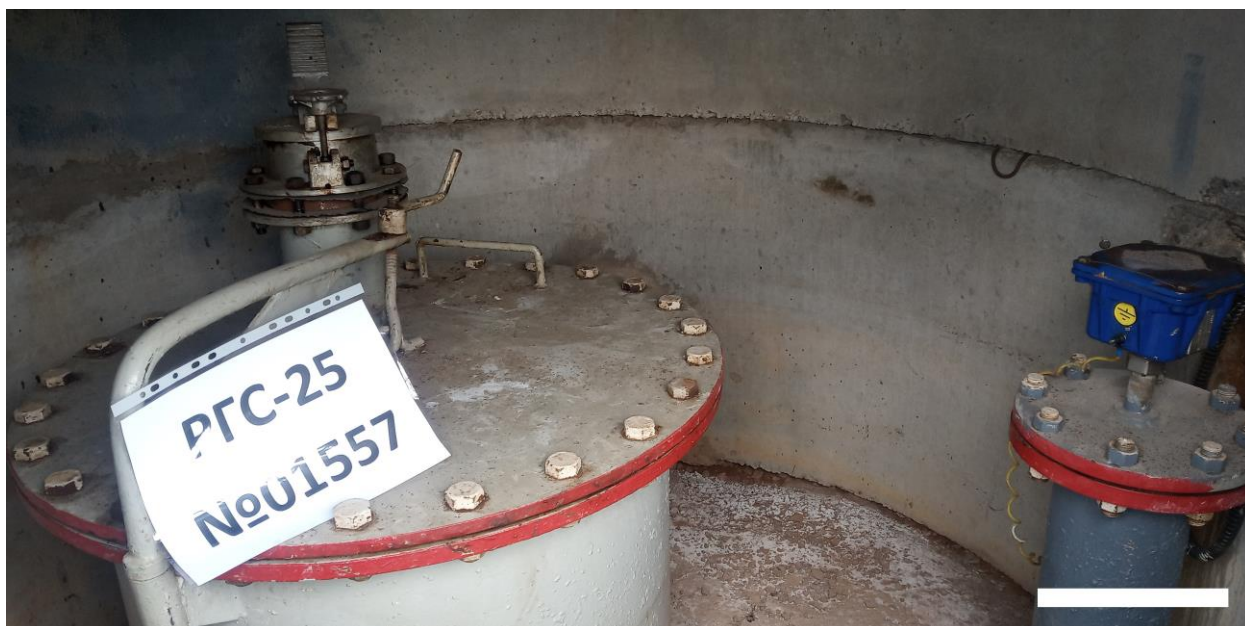
Рисунок 2 – Общий вид заливной горловины
