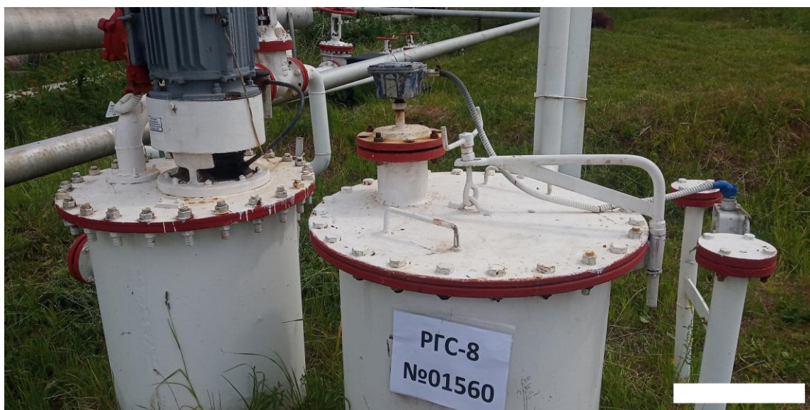
Рисунок 2 – Общий вид заливной горловины
