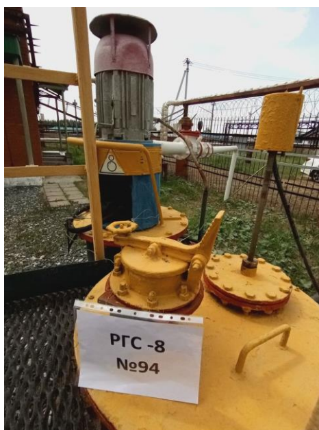
Рисунок 2 – Общий вид заливной горловины
