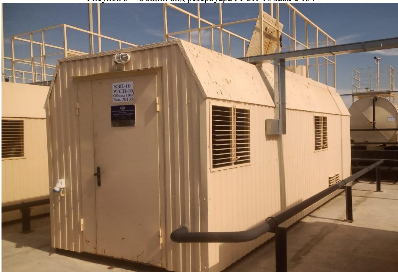
Рисунок 4 – Общий вид резервуара РГСН-10 зав.№ 135
