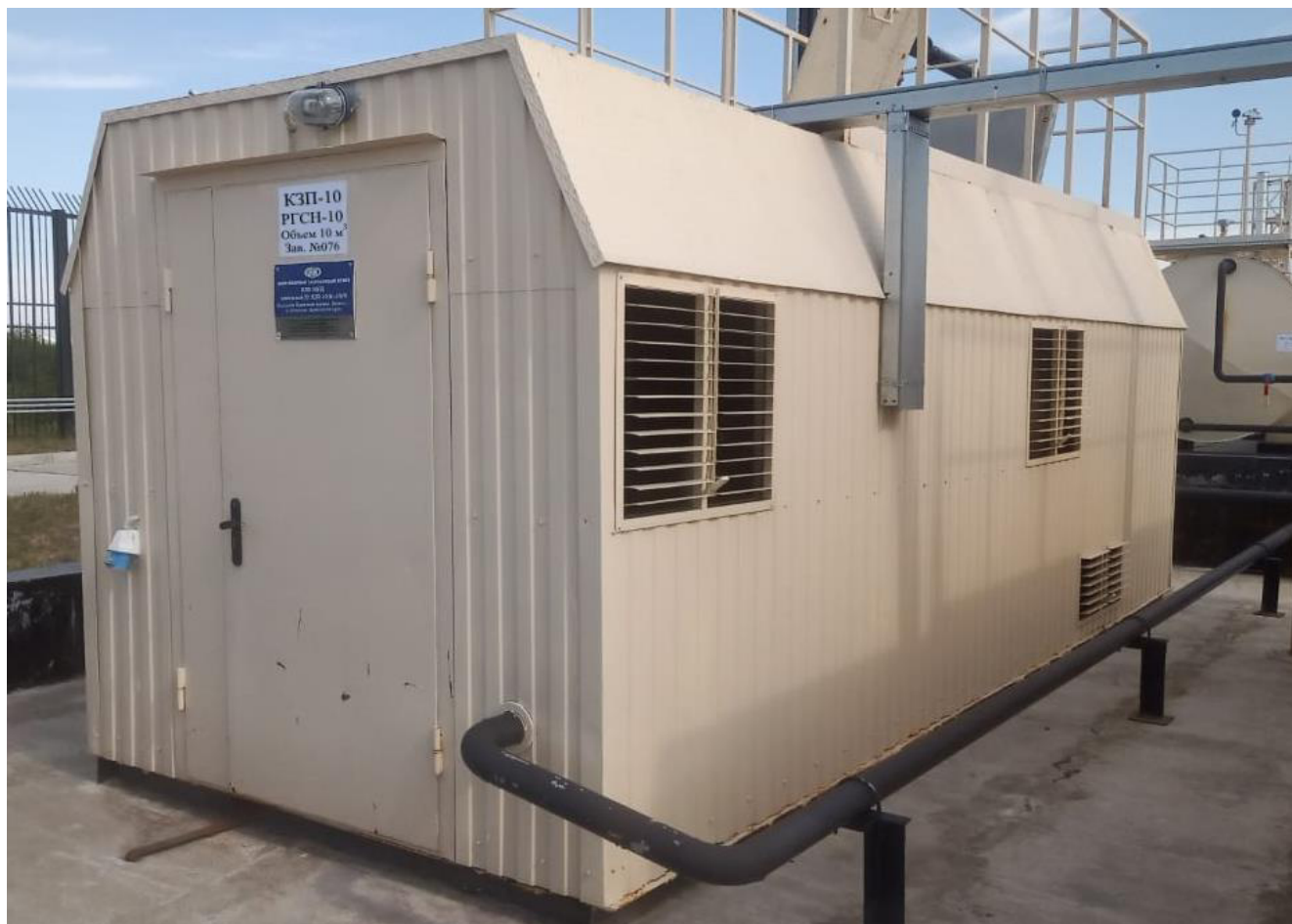
Рисунок 2 – Общий вид резервуара РГСН-10 зав.№ 076
