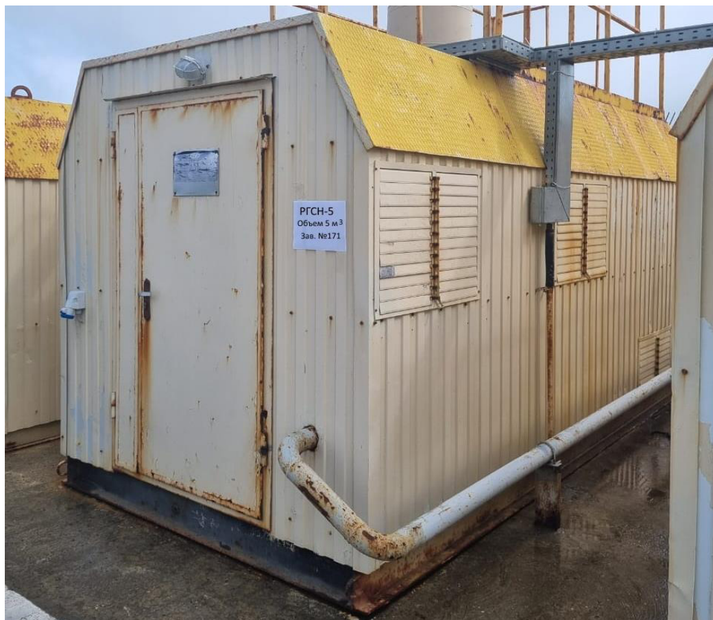
Рисунок 1 – Общий вид резервуара РГСН-5
