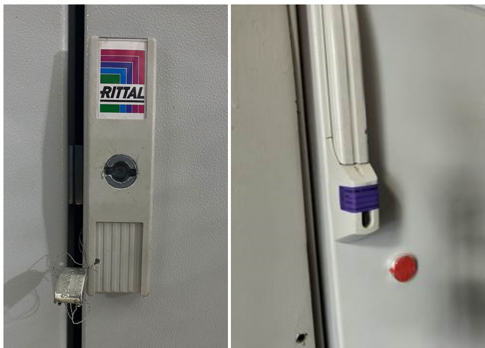
Рисунок 3 – Схема пломбировки шкафов комплекса
