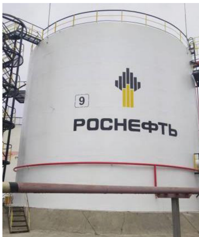
Рисунок 2 – Общий вид резервуара РВСП-2000 №9
