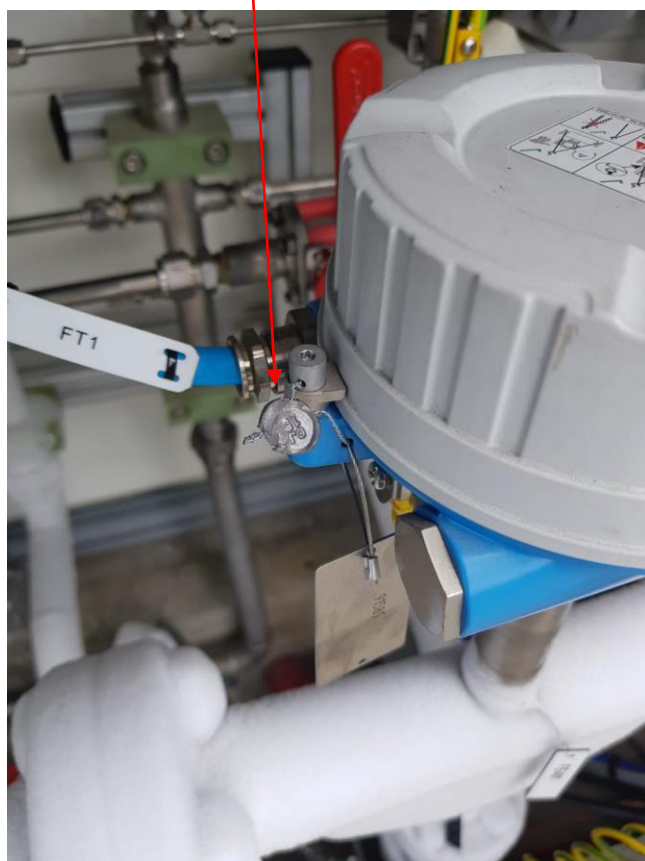
Рисунок 2 – Места нанесения знака поверки в виде пломбы на: преобразователи расхода массовые LNGmass, электронно-вычислительное устройство Cryostar Cryofueltronics, шкаф питания
