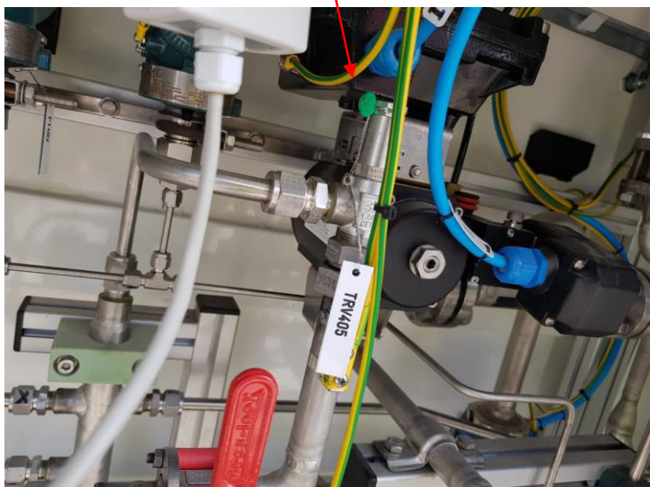
Рисунок 3 – Места нанесения пломбы завода изготовителя к подводющим патрубкам
