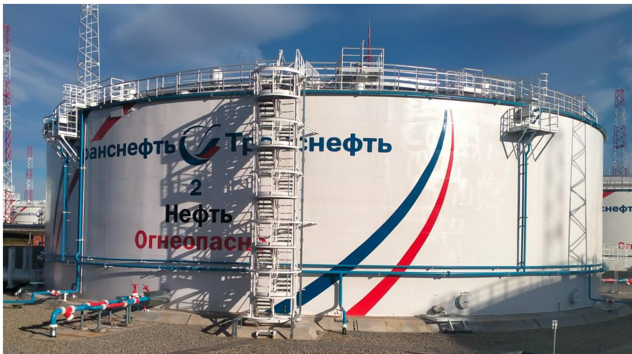
Рисунок 1 – Общий вид резервуара РВСП-20000 №2
