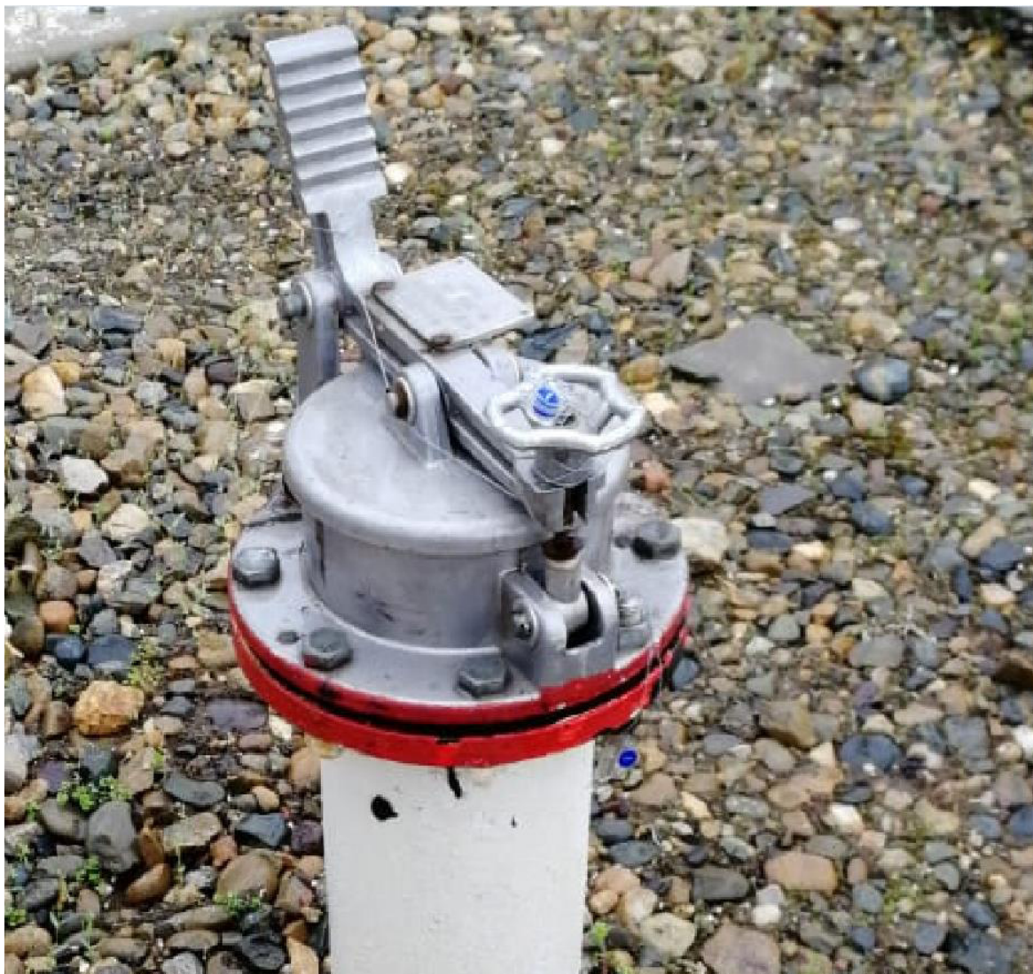
Рисунок 2 - Фотография горловины и крышки замерного люка резервуара
