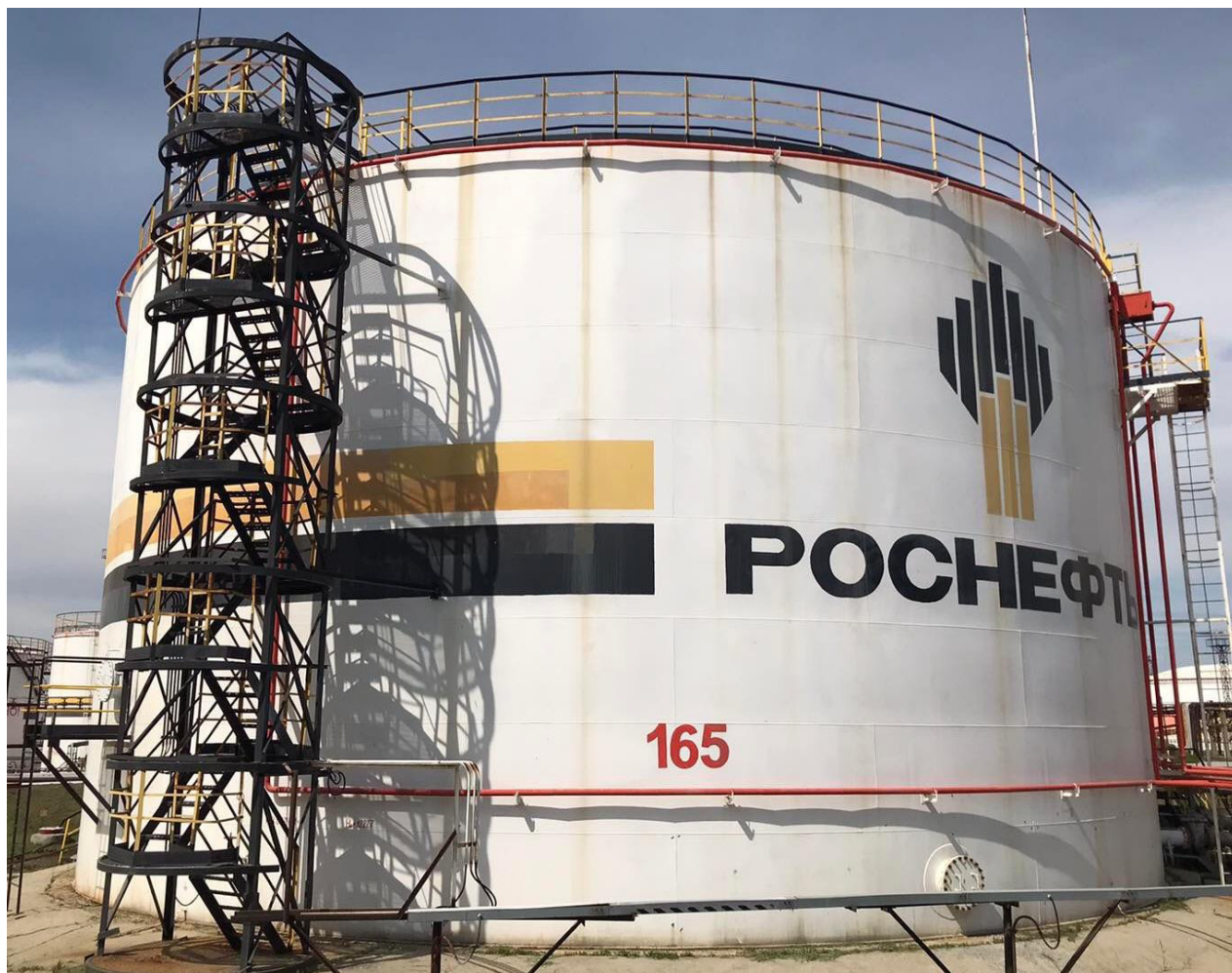
Рисунок 1 – Общий вид резервуара РВСП-5000 №165
