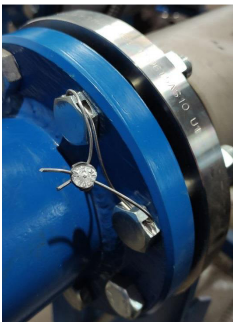
Рисунок 3 – Схема пломбировки фланцев счетчиков-расходомеров массовых
