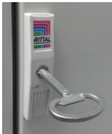
Рисунок 7 – Замок и ключ шкафа коммутационного. Вид общий
