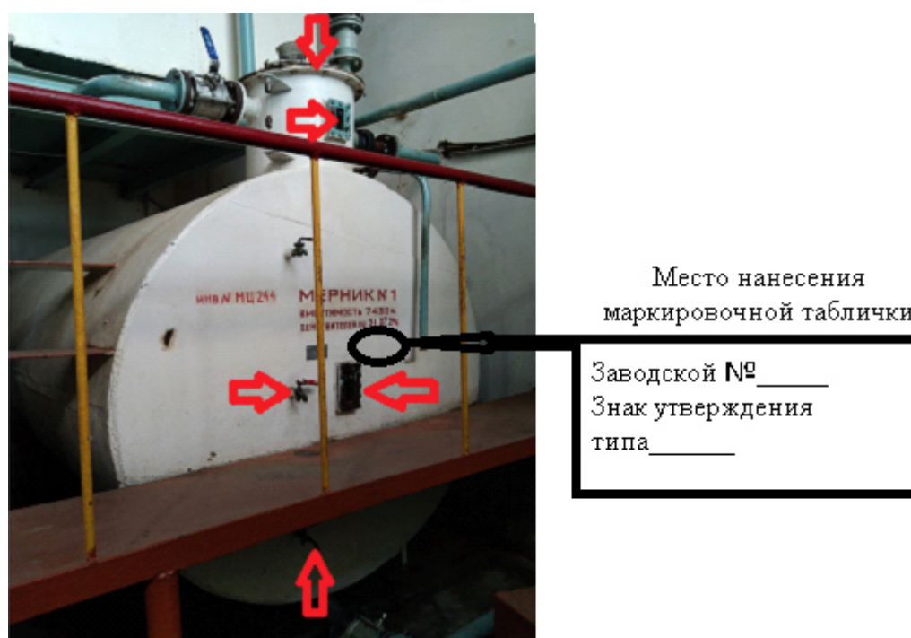
Рисунок 2 – Схема пломбировки мерника МТГ-1, зав. № 1 от несанкционированного доступа, обозначение места нанесения знака поверки, заводского номера и знака утверждения типа
