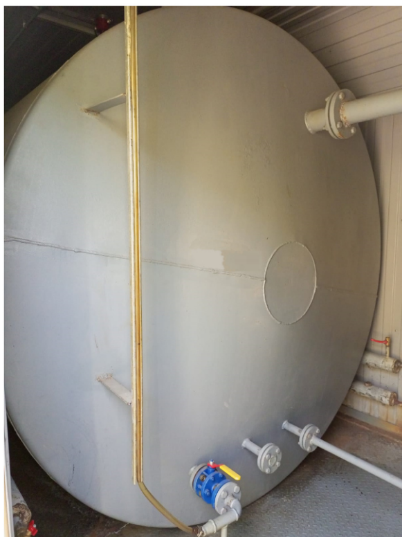
Рисунок 5 – Общий вид резервуара РГС-25 зав.№ 138 с указанием места нанесения заводского номера
