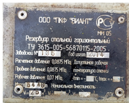
Рисунок 3 – Общий вид резервуара РГС-25 зав.№ 136 с указанием места нанесения заводского номера
