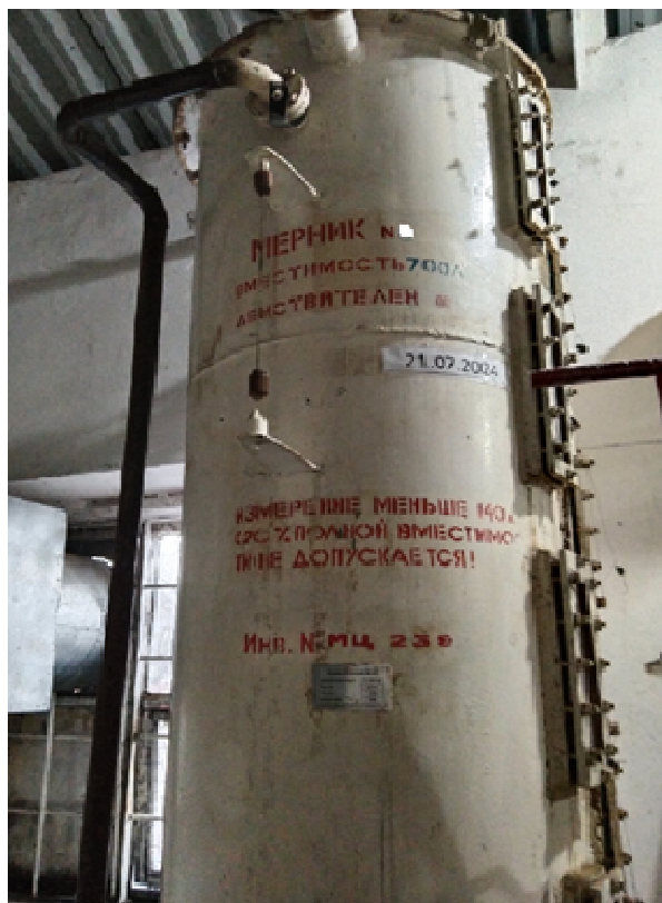
Рисунок 13 – Общий вид мерников МТВ-1, зав. № 31
