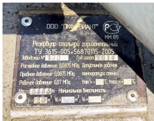
Рисунок 5 – Общий вид резервуара РГС-25 зав.№ 138 с указанием места нанесения заводского номера
