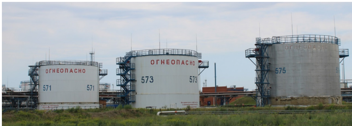
Рисунок 1 - Общий вид резервуаров стальных вертикальных цилиндрических РВС-2000
