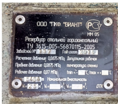
Рисунок 4 – Общий вид резервуара РГС-25 зав.№ 137 с указанием места нанесения заводского номера
