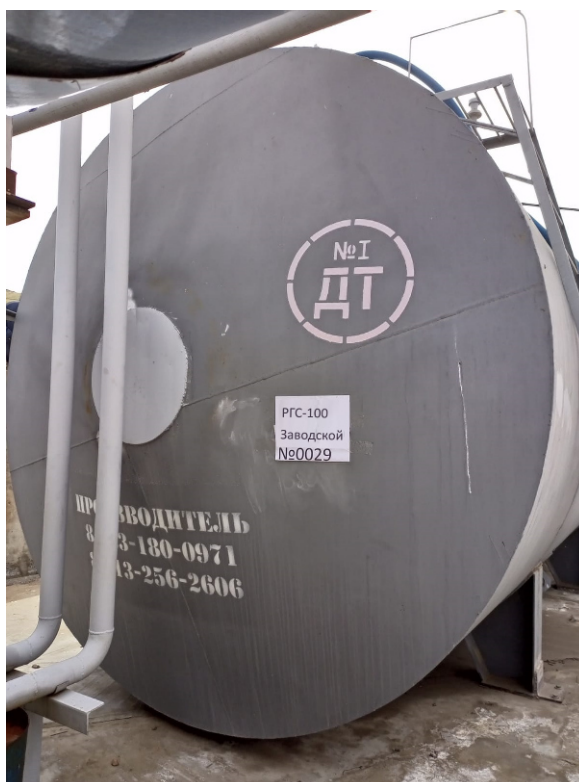
Рисунок 1 – Общий вид резервуара РГС-100 зав.№ 0029
