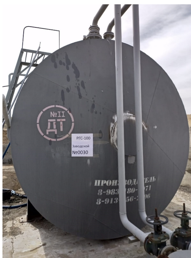
Рисунок 2 – Общий вид резервуара РГС-100 зав.№ 0030
