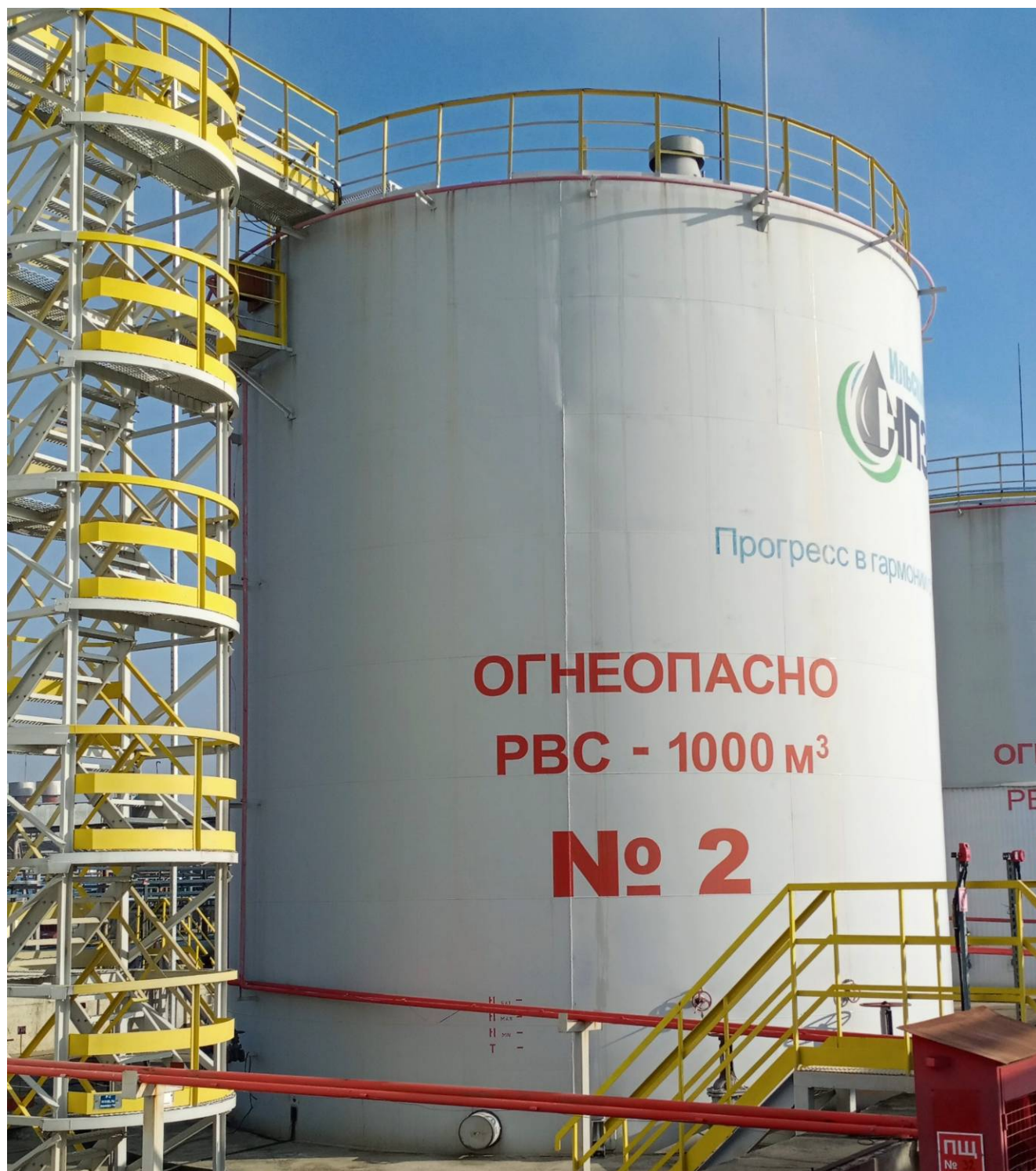
Рисунок 2 - Фотография общего вида резервуара РВС-1000 заводской номер 2.
