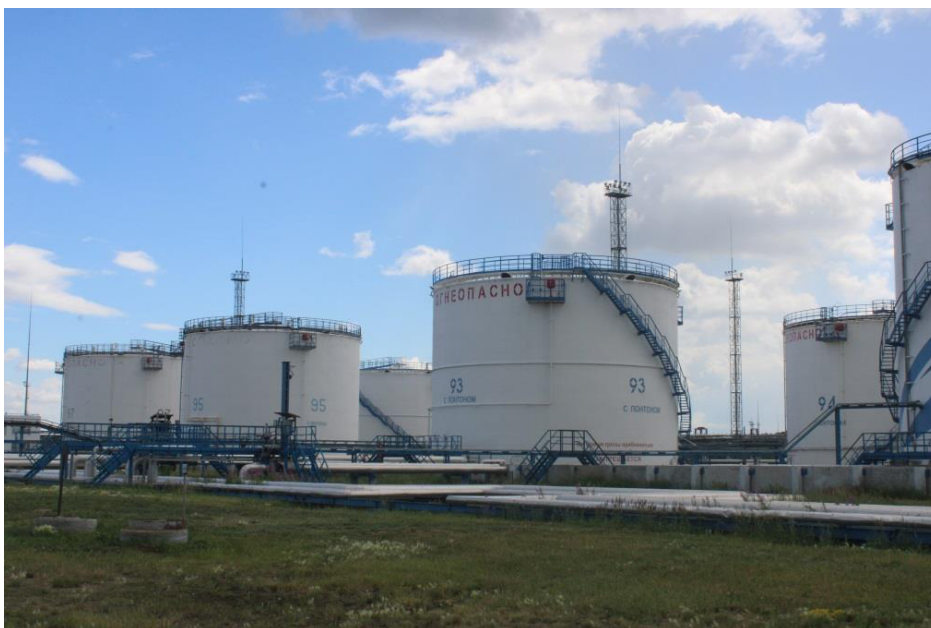
Рисунок 2 – Общий вид резервуаров стальных вертикальных цилиндрических РВС-5000.
