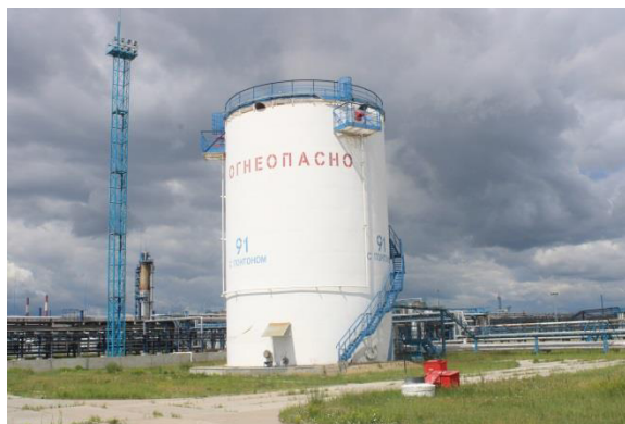
Рисунок 1 – Общий вид резервуара стального вертикального цилиндрического РВС-2000.
