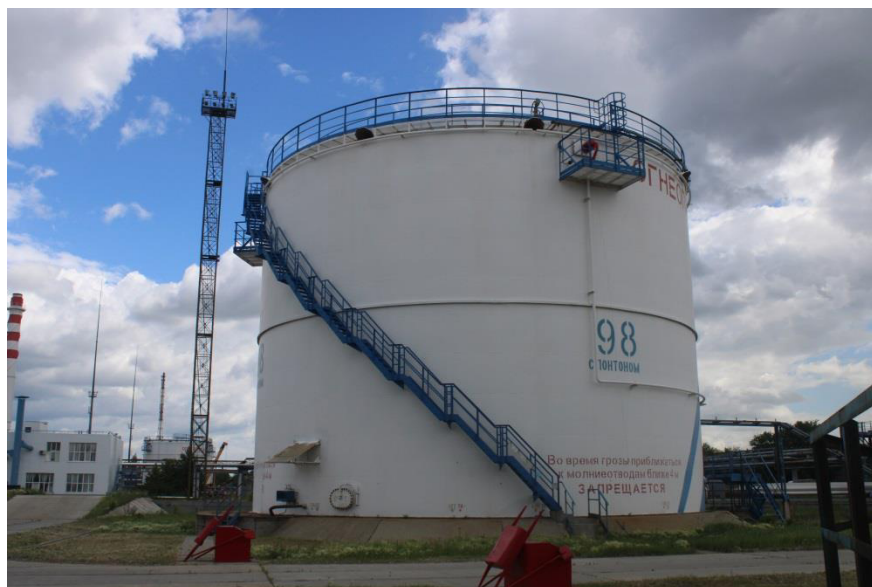
Рисунок 2 – Общий вид резервуаров стальных вертикальных цилиндрических РВС-5000.
