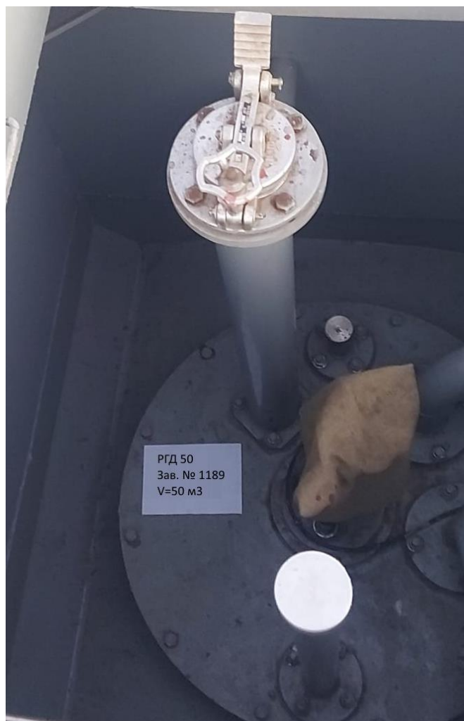
Рисунок 2 – Горловина резервуара РГД 50 зав.№ 1189
