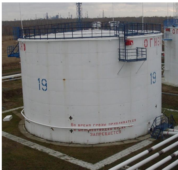
Рисунок 2 - Общий вид резервуаров стальных вертикальных цилиндрических РВС-3000.
