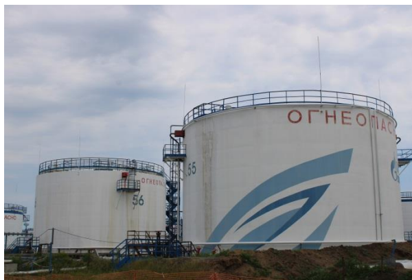
Рисунок 1 - Общий вид резервуара стального вертикального цилиндрического РВС-3000.
