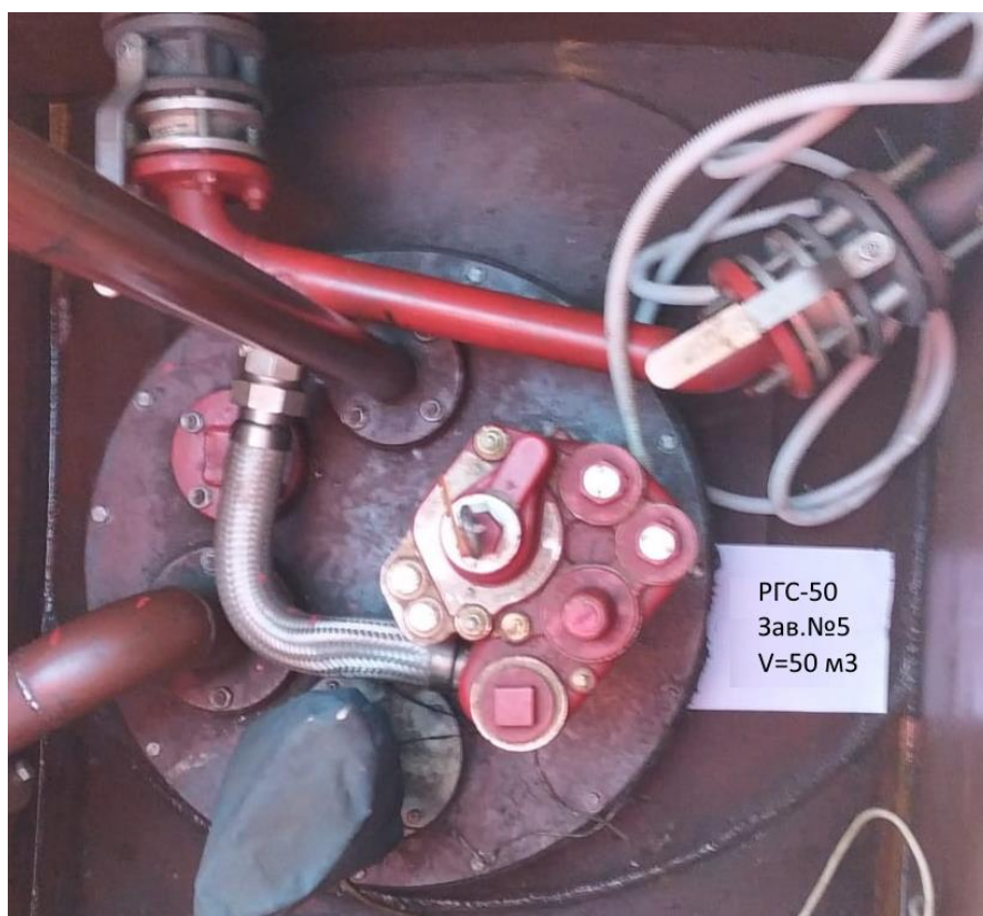
Рисунок 2 – Горловина резервуара РГС-50 зав.№5
