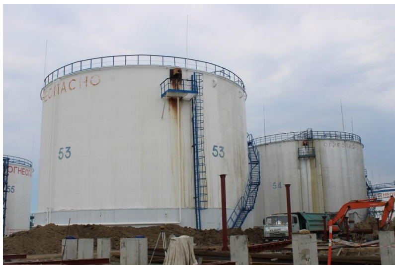
Рисунок 2 - Общий вид резервуаров стальных вертикальных цилиндрических РВС-5000.
