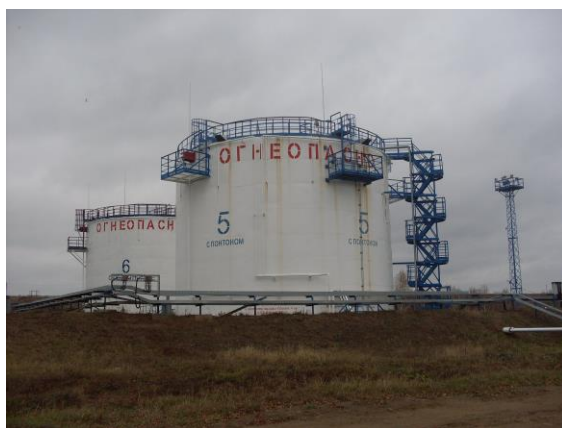
Рисунок 1 - Общий вид резервуаров стальных вертикальных цилиндрических РВСП-2000
