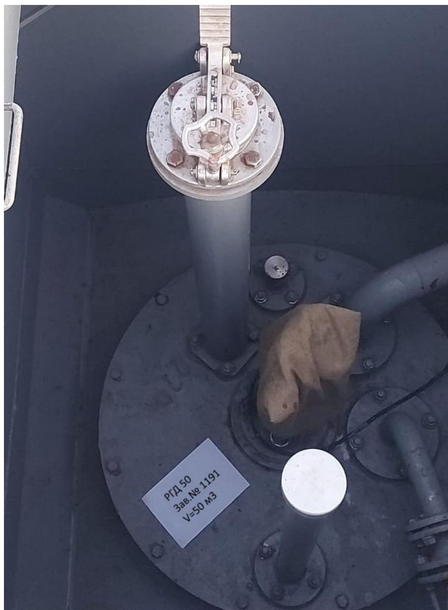
Рисунок 3 – Горловина резервуара РГД 50 зав.№ 1191
