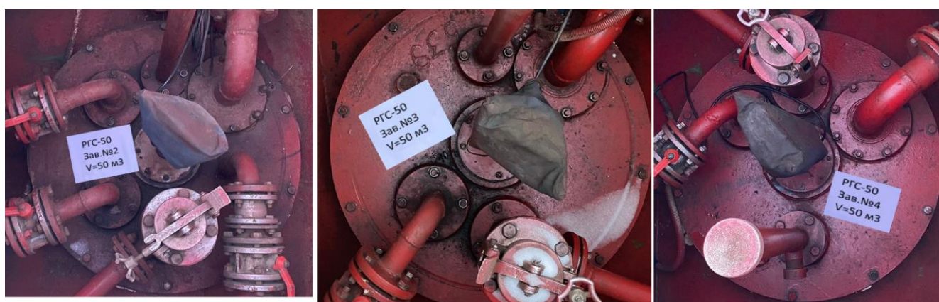
Рисунок 3 – Горловины резервуаров РГС-50 зав.№№ 2, 3, 4
