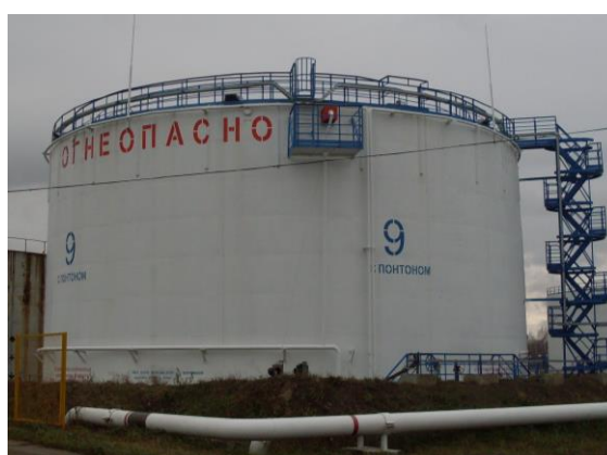
Рисунок 3 - Общий вид резервуара стального вертикального цилиндрического РВСП-5000
