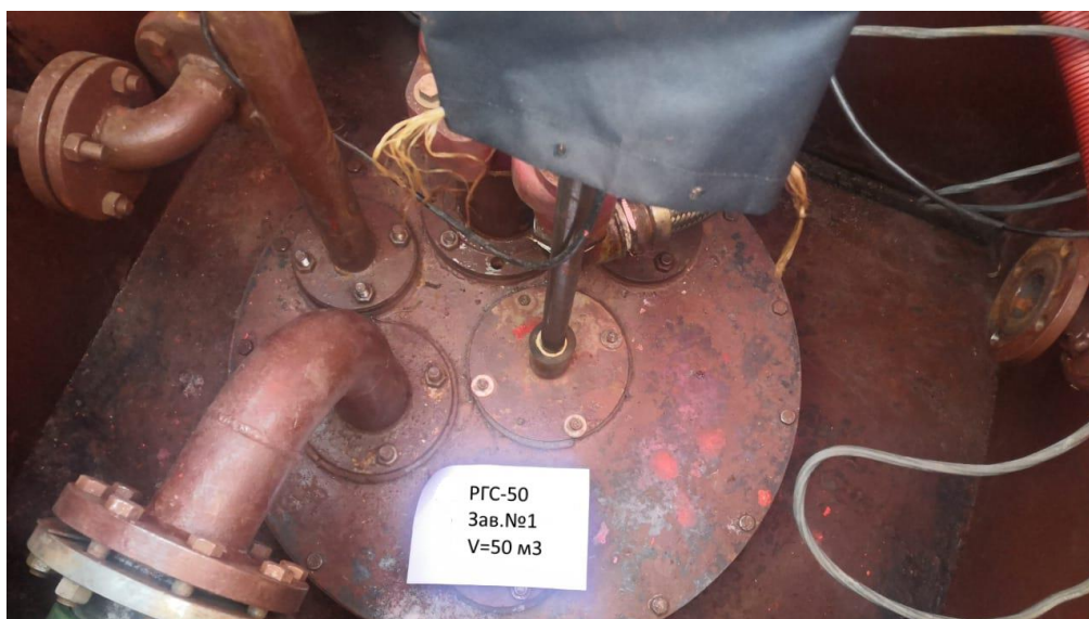
Рисунок 3 – Горловина резервуара РГС-50 зав.№ 1
